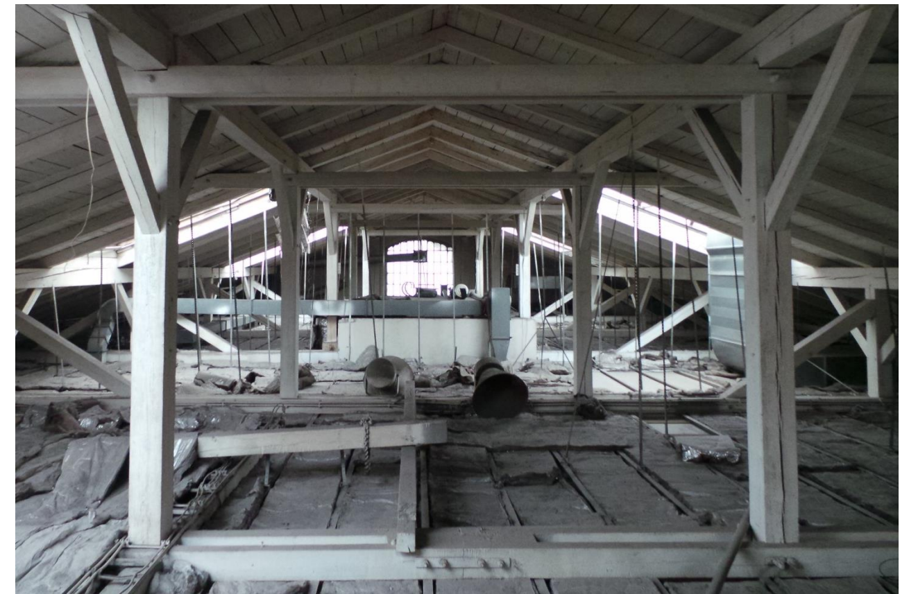
Pohľad do krovu nad podhlľadom
