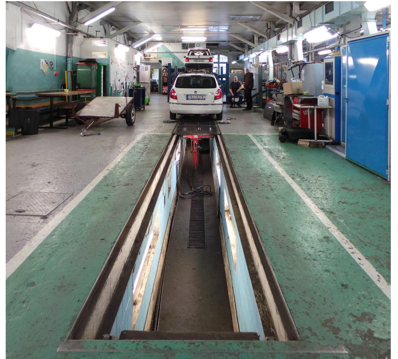
Povrch súčasnej stierkovej podlahy a montážna jama
