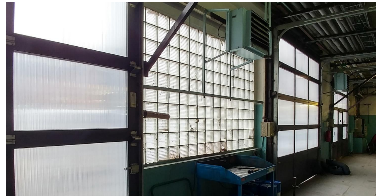
Severné priečelie vozovne, pohľad z interiéru
