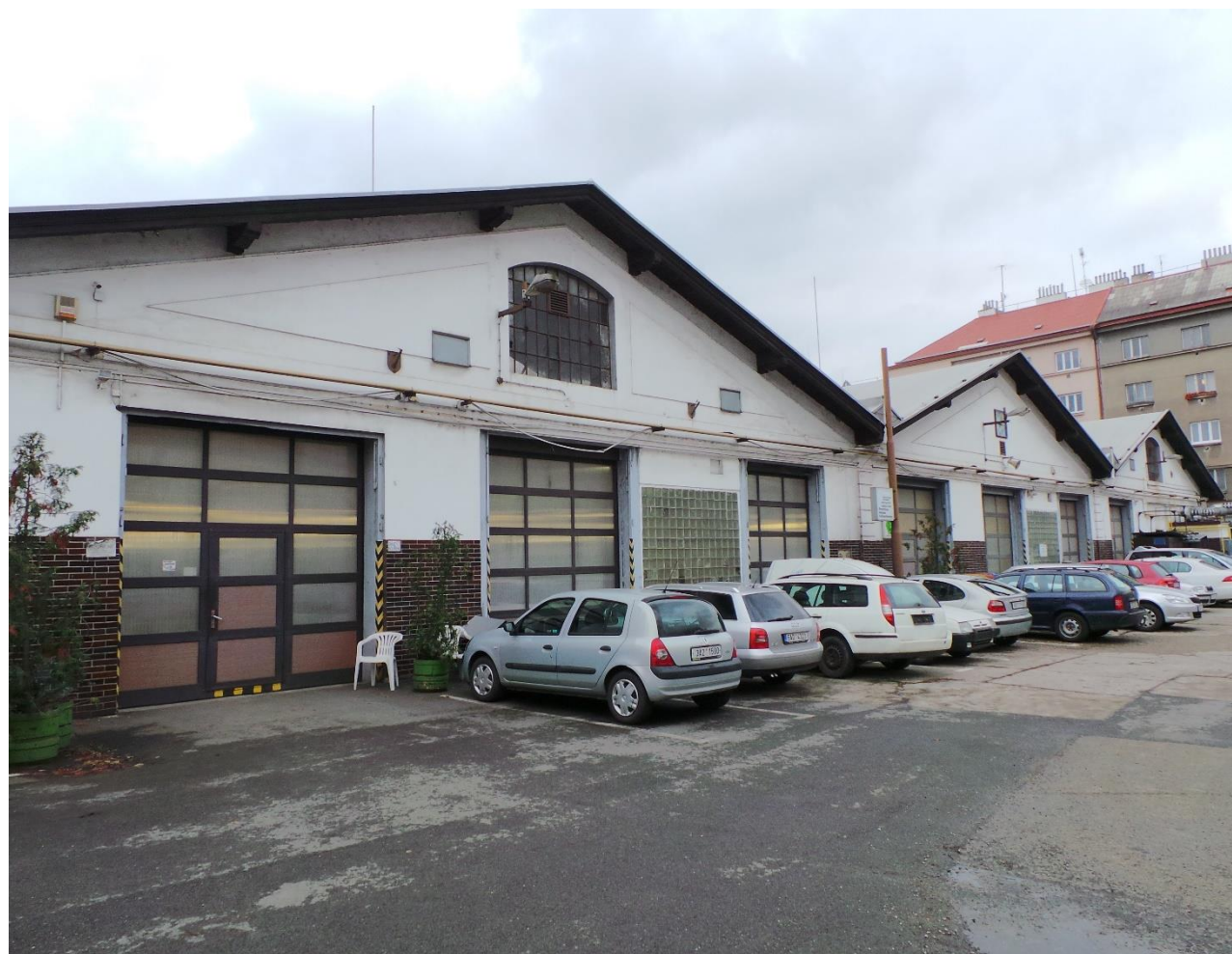
Súčasný stav severnej fasády
