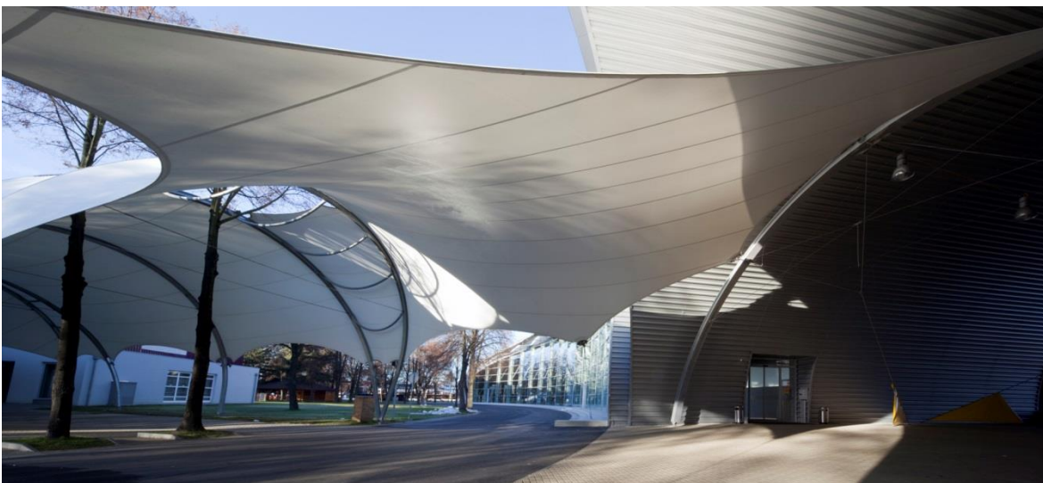
Obr. 10: Zastřešení koridoru výstaviště v Českých Budějovicích [61]
