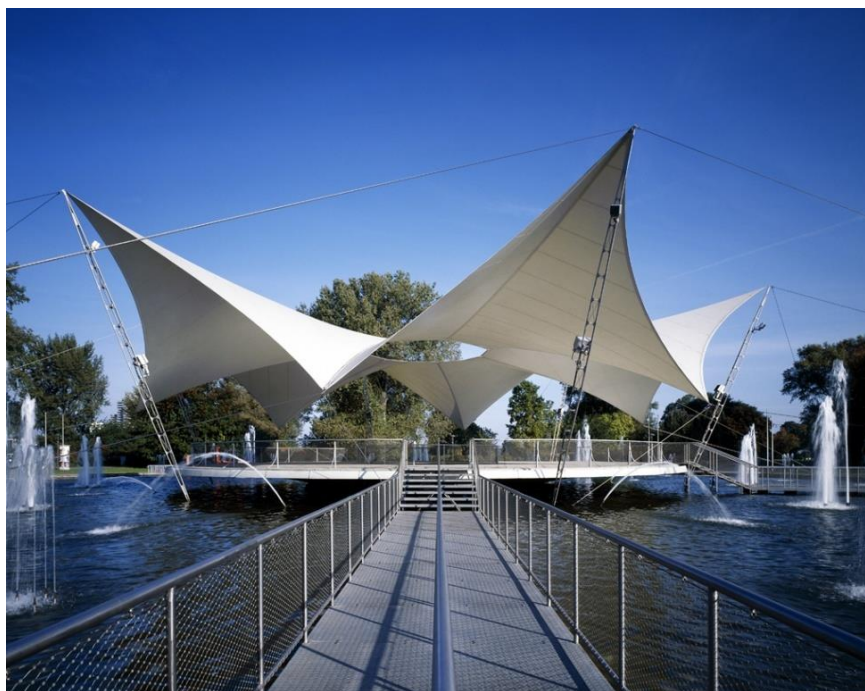
Obr. 2: Příklad lanoplachtové konstrukce [51]
