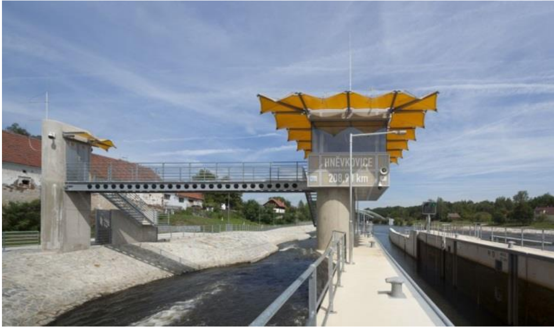
Obr. 13: Membránové stínění velínu v Hněvkovicích [64]
