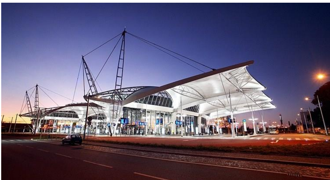
Obr. 8: Zastřešení autobusového terminálu v Hradci Králové [59]
