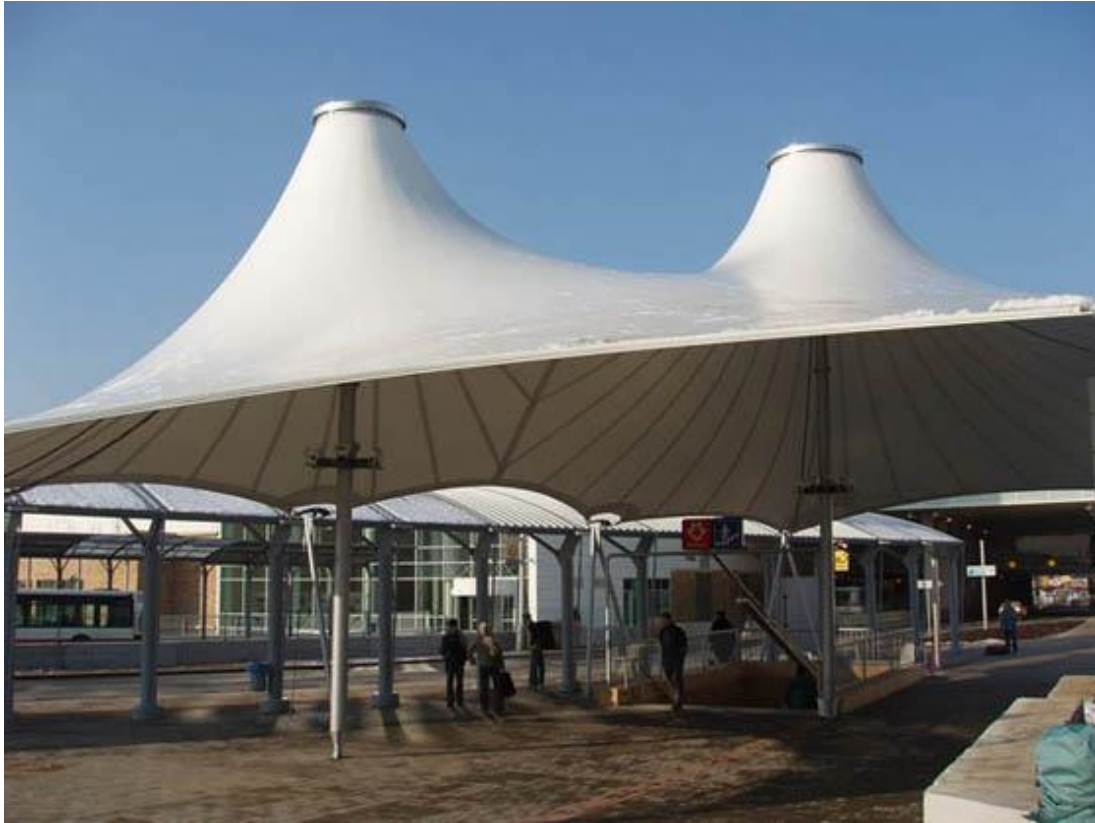
Obr. 9: Zastřešení výstupu z metra stanice Chodov [60]
