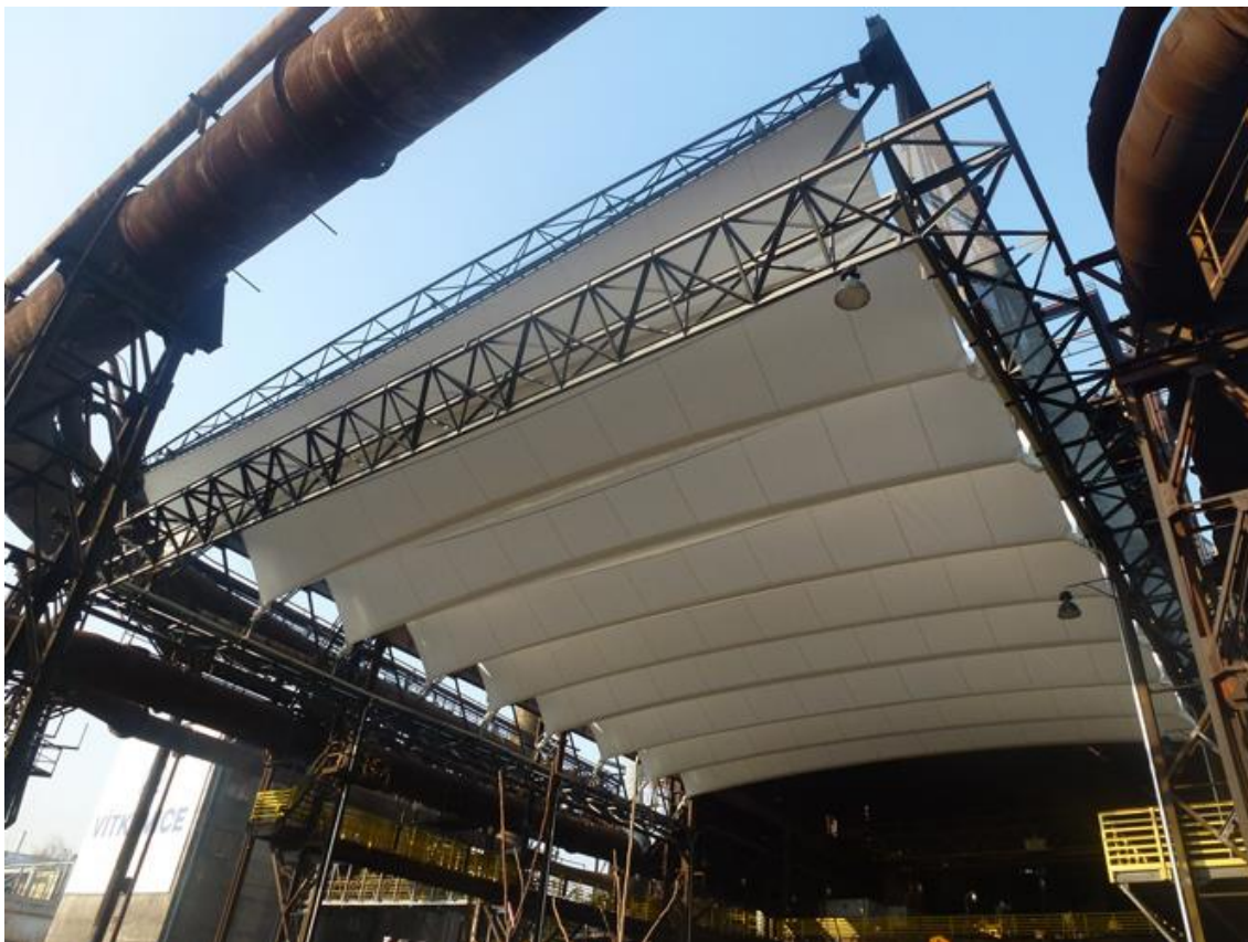
Obr. 14: Zastřešení kulturní scény ve Vítkovicích [65]
