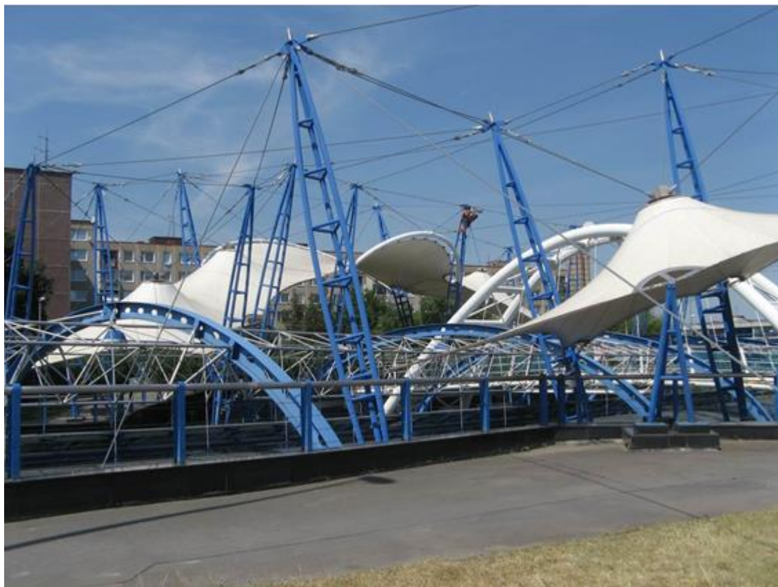
Obr. 87: Boční (jižní) pohled na zkoušenou konstrukci [70]
