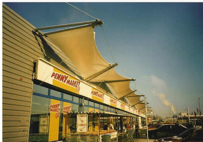
Obr. 1: Membránová konstrukce, u níž došlo v roce 1999 k havárii [1]
