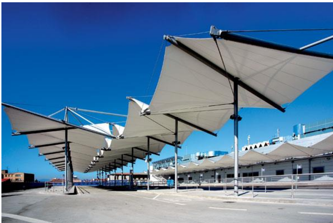
Obr. 11: Zastřešení terminálu autobusů v Českých Budějovicích [62]
