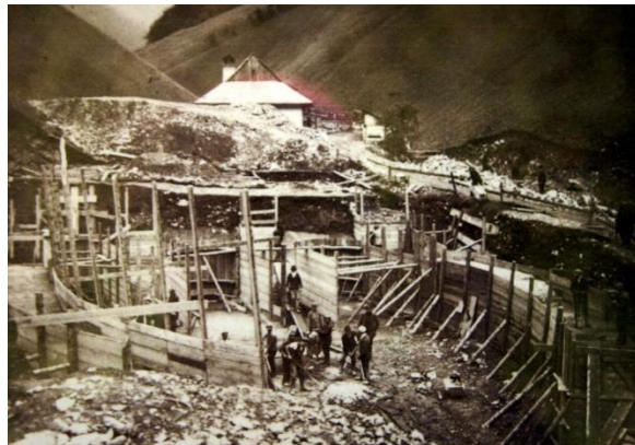
Obrázek 68- výstavba nádrže Jelenec, 1924
