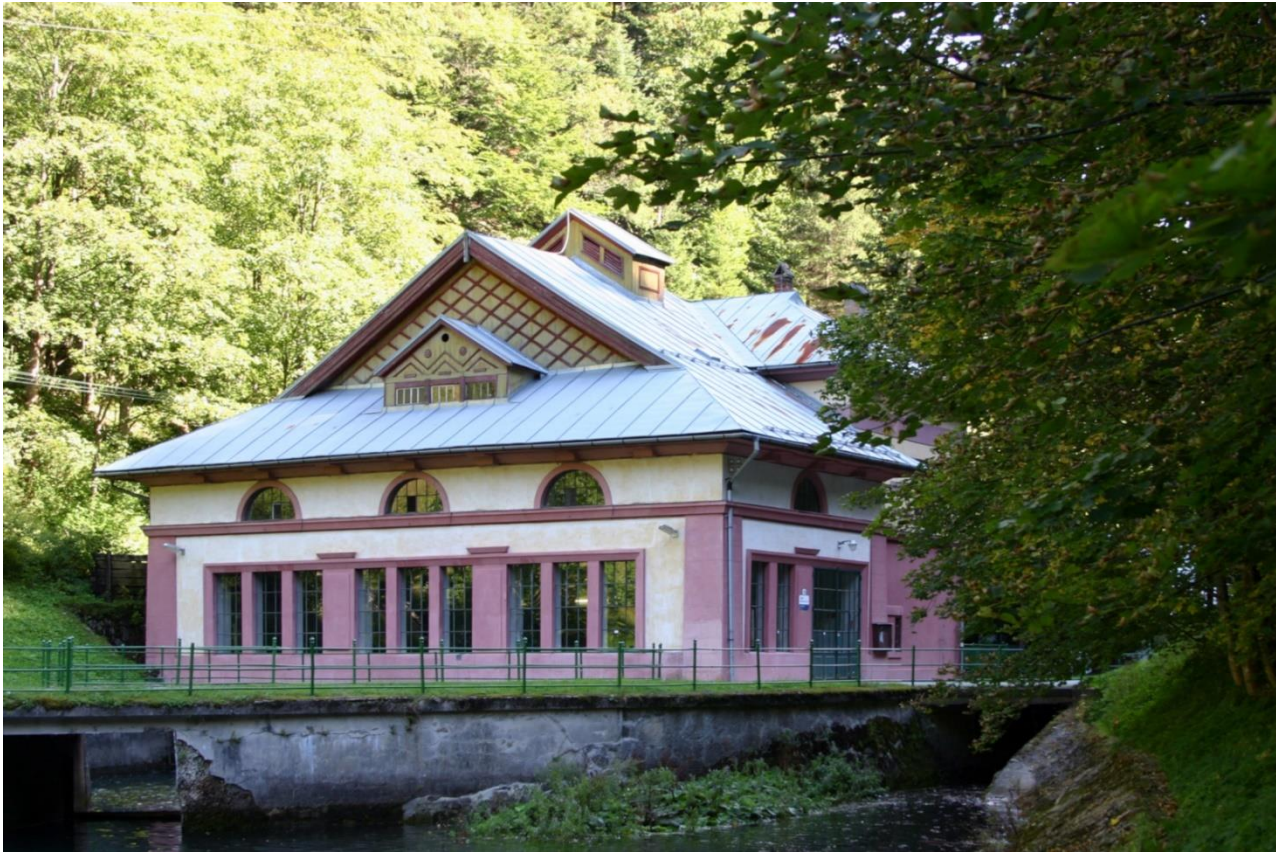
Obrázek 66 - hydroelektrárna Dolný Jelenec, 1924 208
