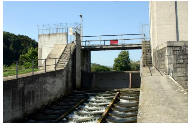
Obrázek 129 – vorova propušť, Dolní Kočkovce, 1932 300
