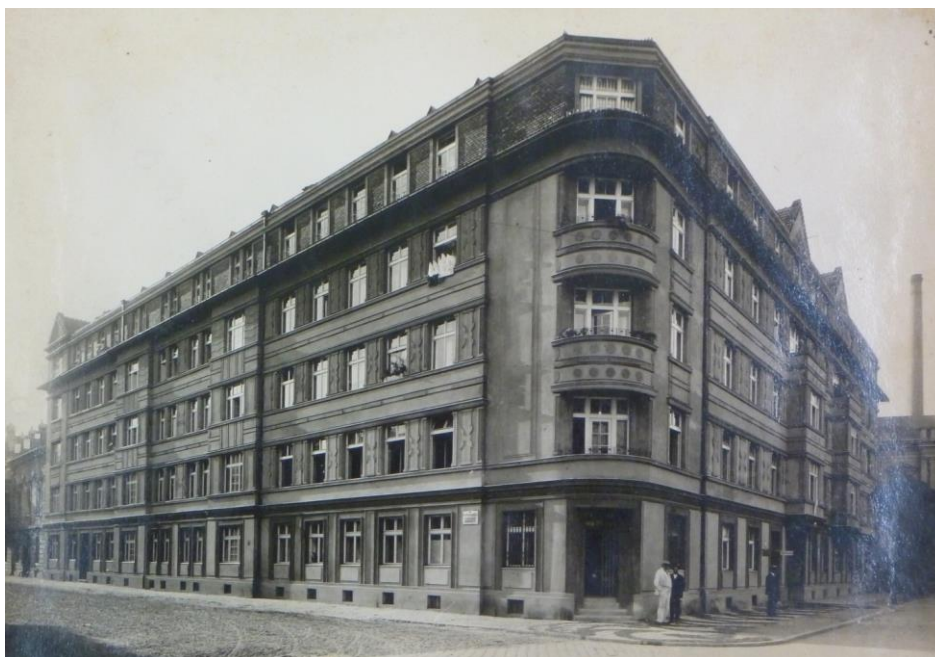
Obrázek 56 - bytový dům pro zaměstnance finančních úřadů na Meděnej, 1921 193
