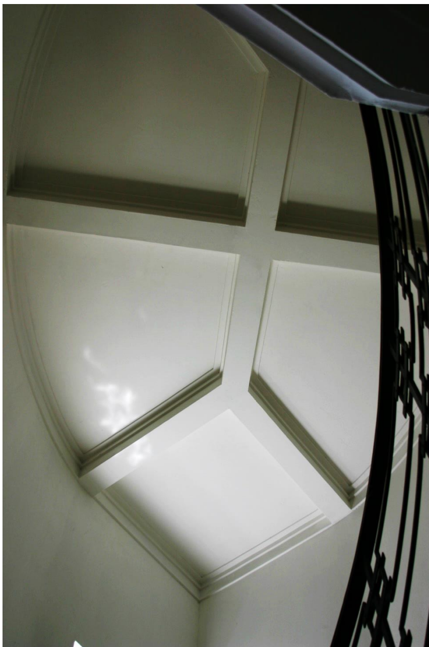
Obrázek 52 - detail schodiště bytového domu pro Družstvo Slovenský domov 176
