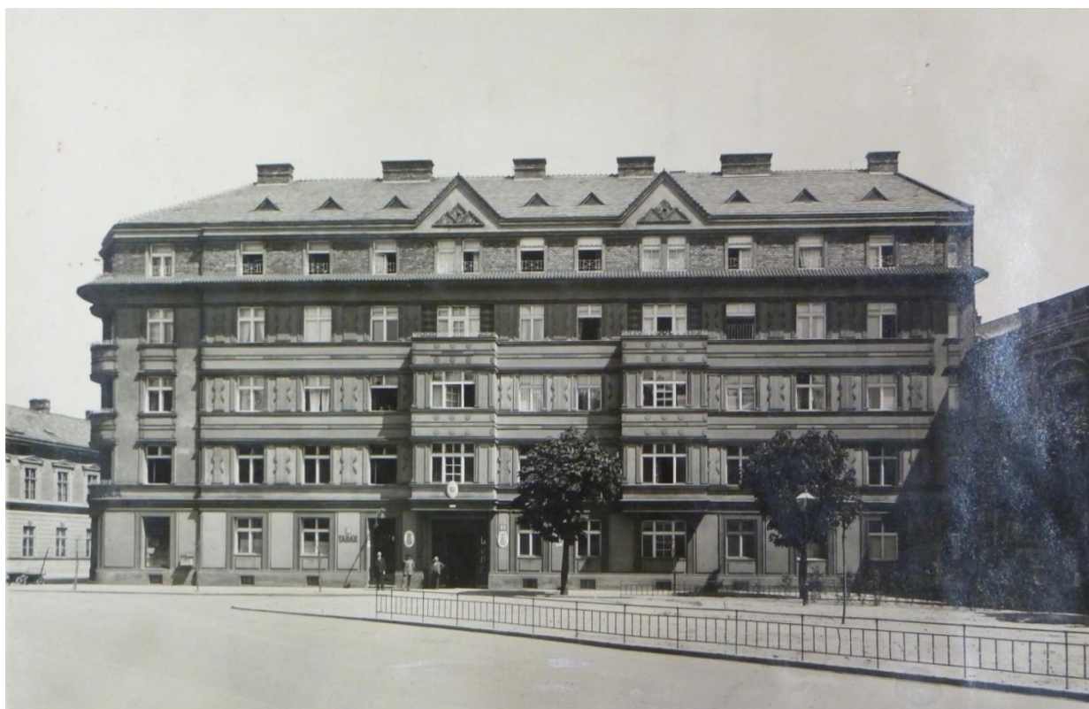
Obrázek 57 - bytový dům pro zaměstnance finančních úřadů na Meděnej, 1921 194
