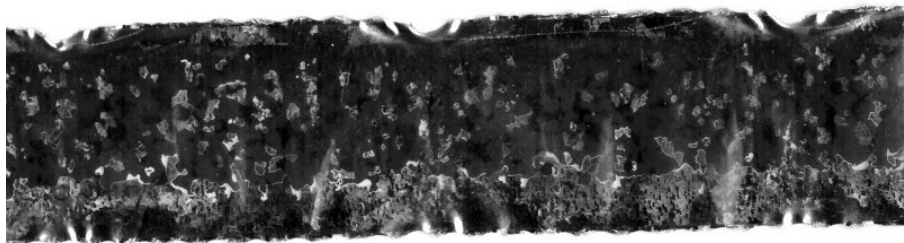
Obrázek 4.20: Degradace tenké kovové vrstvy
