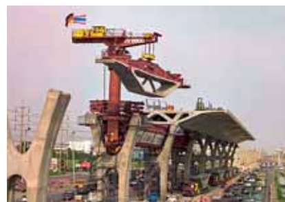
Expressway Bangkok, montáž segmentů
