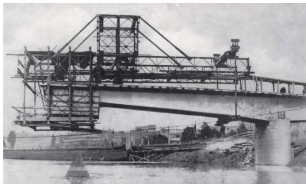
Betonážní vozík mostu na Veslařský ostrov, Praha Foto: SSŽ, n. p., Praha
