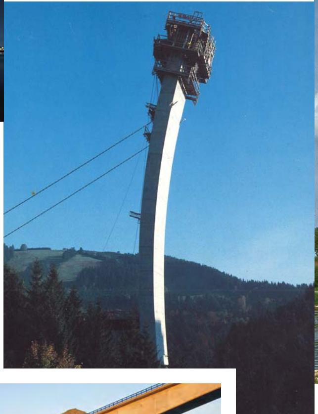
Most Argentobel – betonování poloviny oblouku Foto: Vorspann-Technik
