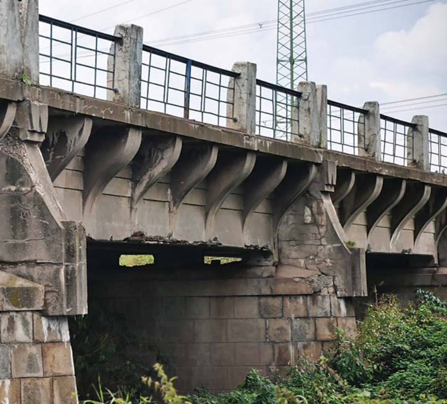
Architektura mostu navržena F. Sanderem
