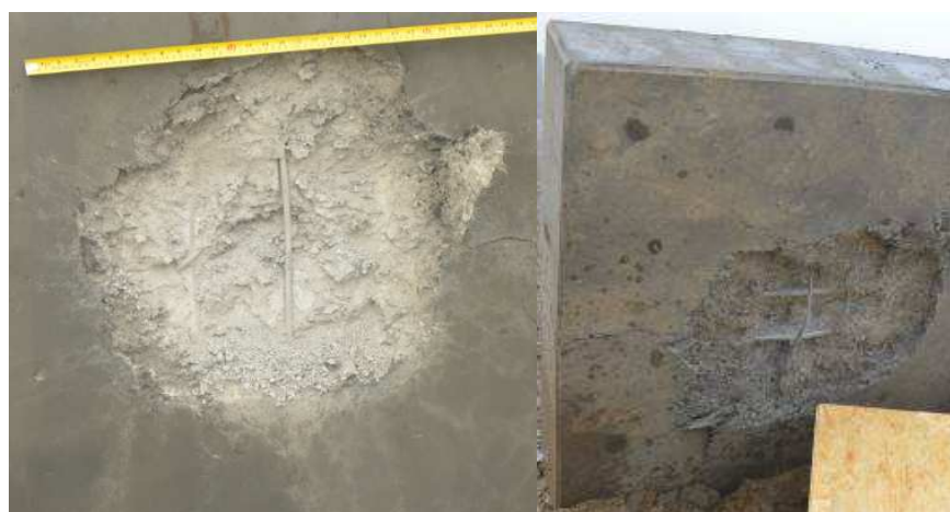
Obr. 2. Kontaktní strana (vlevo) a odvrácená strana (vpravo) poškozená kontaktním výbuchem s výbušninou o hmotnosti 2,8 kg
