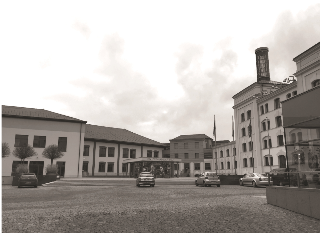
Рис. 1. Здание пивоварни в г. Градец Кралове (1844—1846 гг) реконструированное в 2005—2007 гг под районную государственную администрацию, центр европейского проектирования, региональные правительственные организации, филиал Карлового университета, Галерею Владимира Прецлика, а так же мини-пивовар (с музеем), ресторан «Новый пивовар» и парковку. Памятник культуры Чешской республики.
