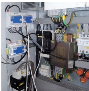
Možnosti stacionární (vlevo) nebo mobilní (vpravo) instalace analyzátorů příkonů pro dlouhodobá měření v řádu měsíců
