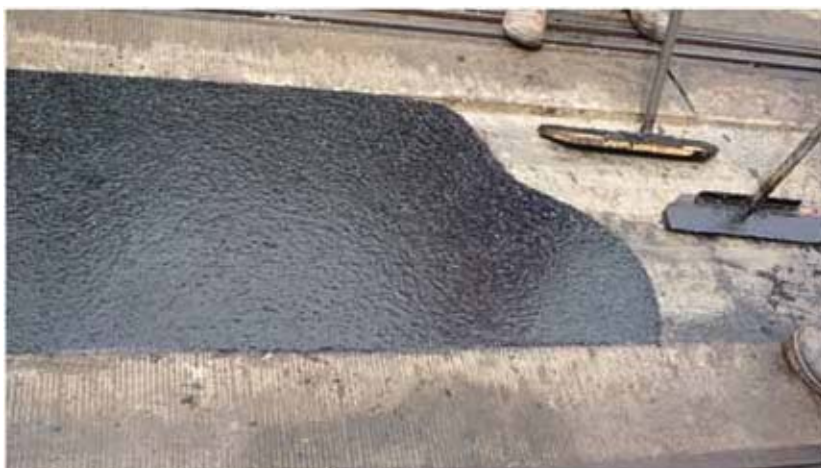
4.ábra: Alacsony hőmérsékletű masztix aszfalt bedolgozása egy hídon.
