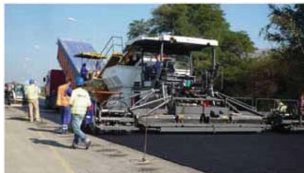
3.ábra: A WMA-t bedolgozó munkaterületen a finisher és az aszfaltszállító (Shuttle Buggy).
