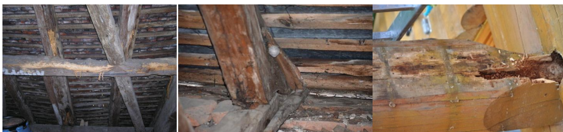
Obrázek č. 10 Poruchy rozpoznatelné pouhým pohledem 23
