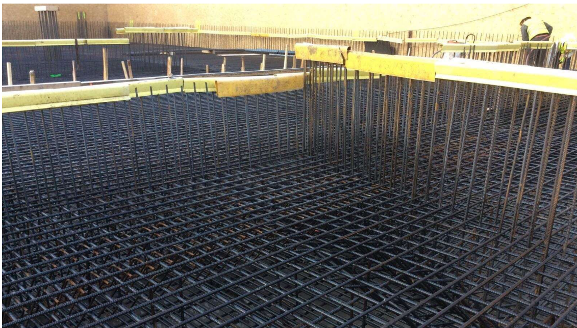
Obrázek 3-7 Dokončené armování základové desky (záběr 5A) před betonáží
