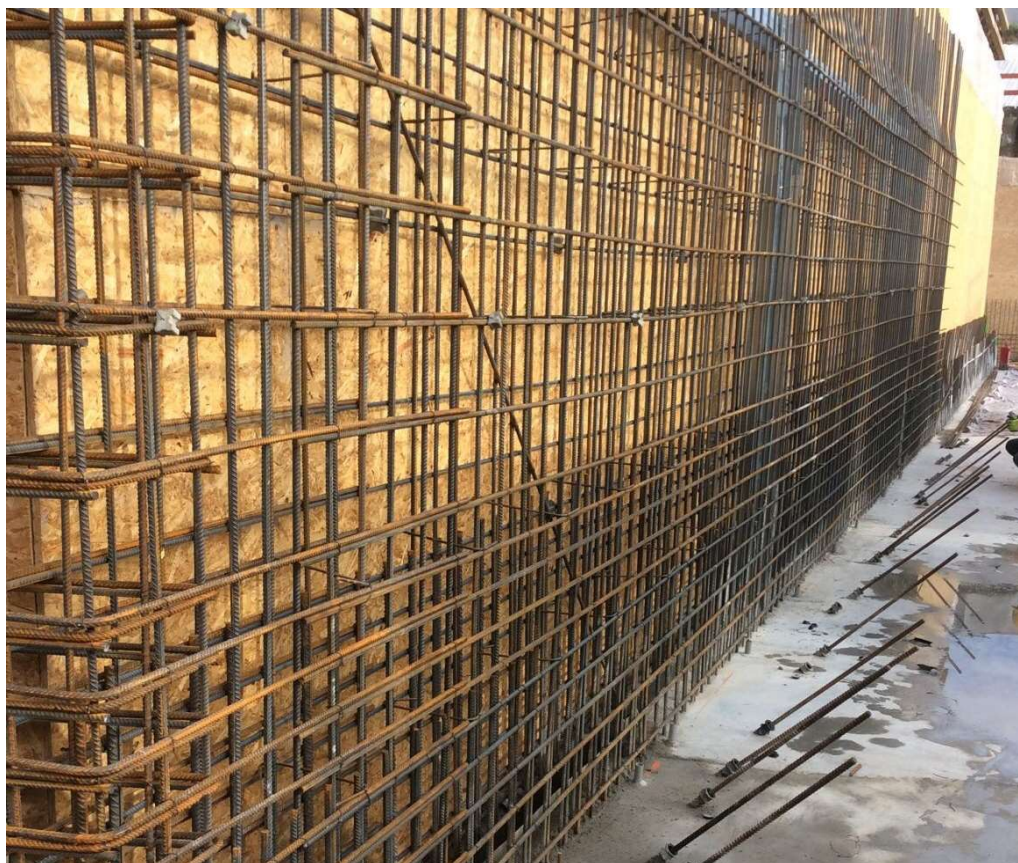
Obrázek 3-11 Dokončení armování stěny 3. PP C03 před záklopem bedněním
