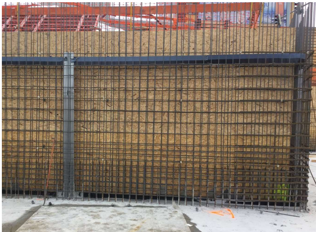
Obrázek 3-11 Dokončení armování stěny 3. PP C03 před záklopem bedněním
