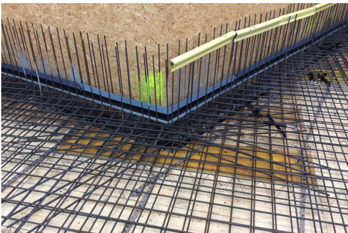
Obrázek 3-7 Dokončené armování základové desky (záběr 5A) před betonáží
