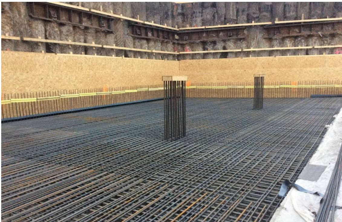
Obrázek 3-9 Dokončené armování základové desky (záběr 9B) před betonáží
