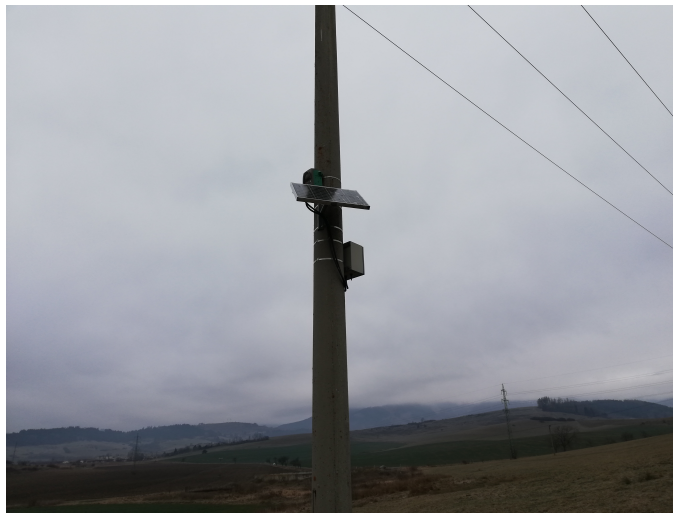
Obrázok 2.9: Príklad smerového indikátora výskytu porúch pre vonkajšie vedenie VN
