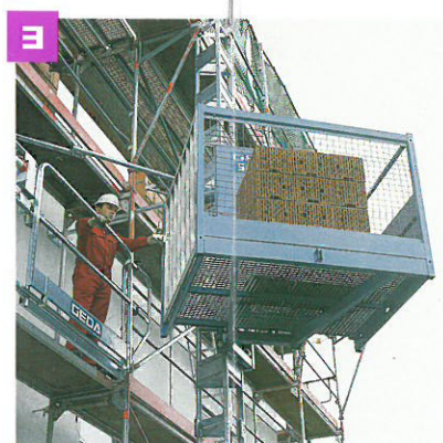
Otáčení nákladní plošiny o 90 stupňů na místě nakládky umožňuje bezpečné překonání volné mezery. Také připojení držáků stožáru z otočné plošiny je velmi snadné. Nakládka dole probíhá souběžně s budovou, což šetří místo, a na úzkém chodníku je často rozhodující.
