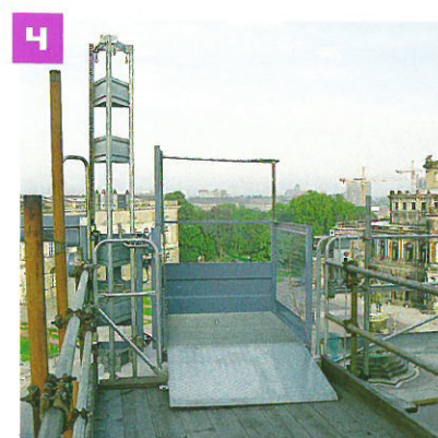
Žárově zinkované elektricky jištěné patrové bezpečnostní zařízení s mechanicky uzavíratelnými zásuvnými dveřmi, stejně jako integrované ovládání, zajišťuje bezpečnost místa vykládky.
