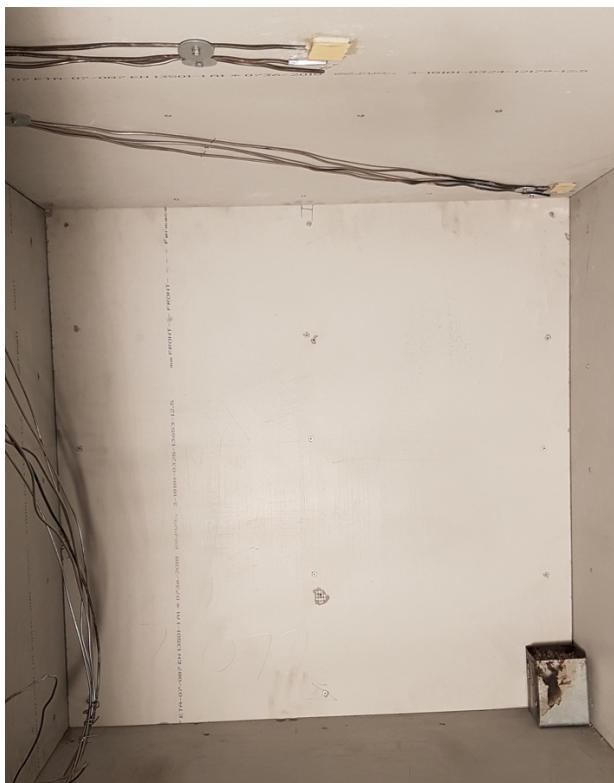
obr. 46: vnitřek zkušební místnosti s TC pod stropem a propanovým hořákem v rohu
