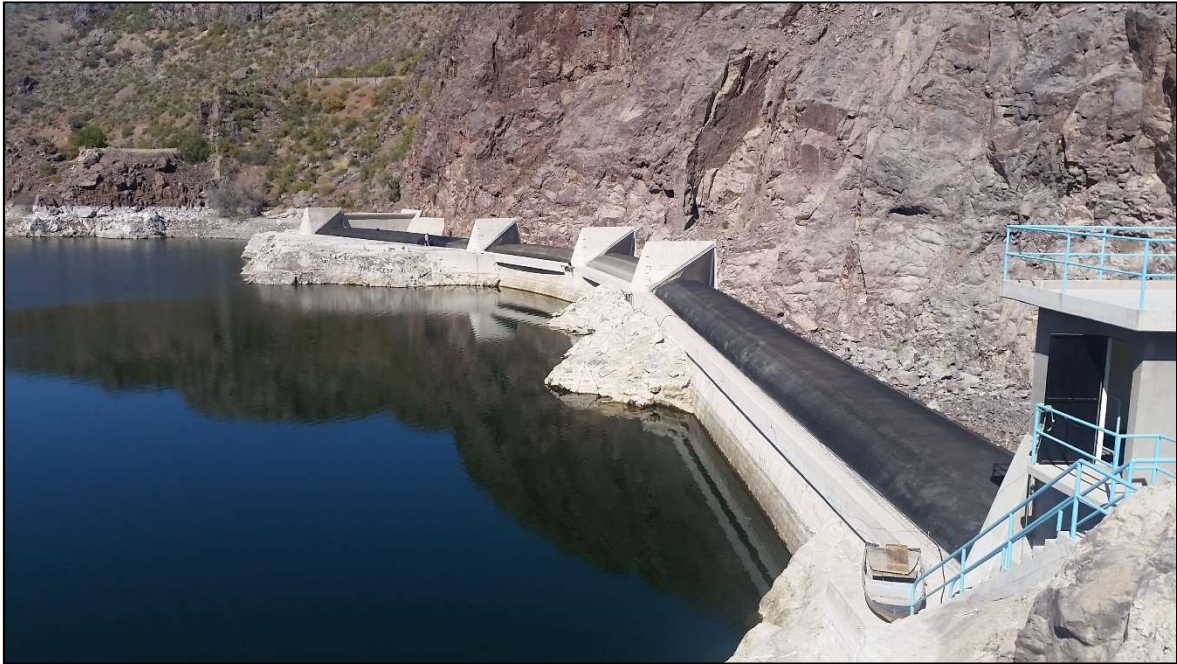
Obr. 1.4 – Bezpečnostní přeliv s pohyblivým vakovým uzávěrem
