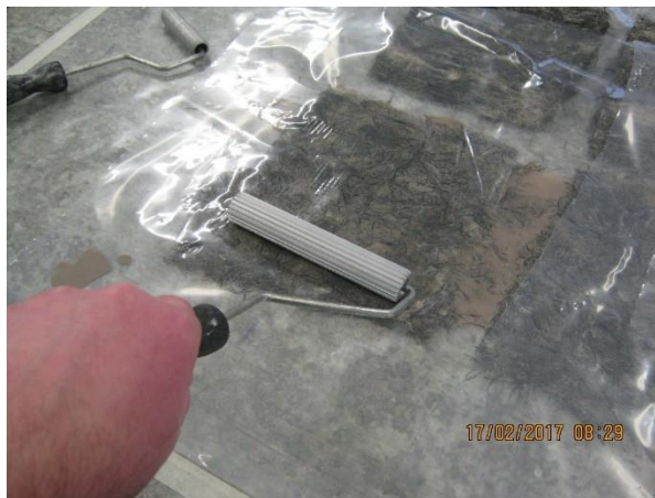
Obrázek 10 - Zpracování geopolymerního pojiva do výztuže [17]
