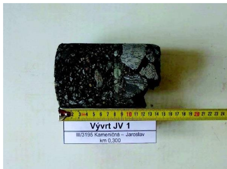
Obrázek 2.3 – Detail jádrového vývrtu ve staničení 0,300 km
