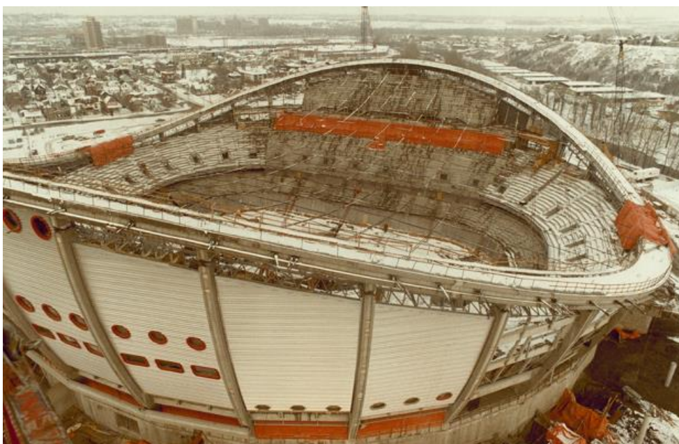
Obr. 15 Hala během výstavby [10]
