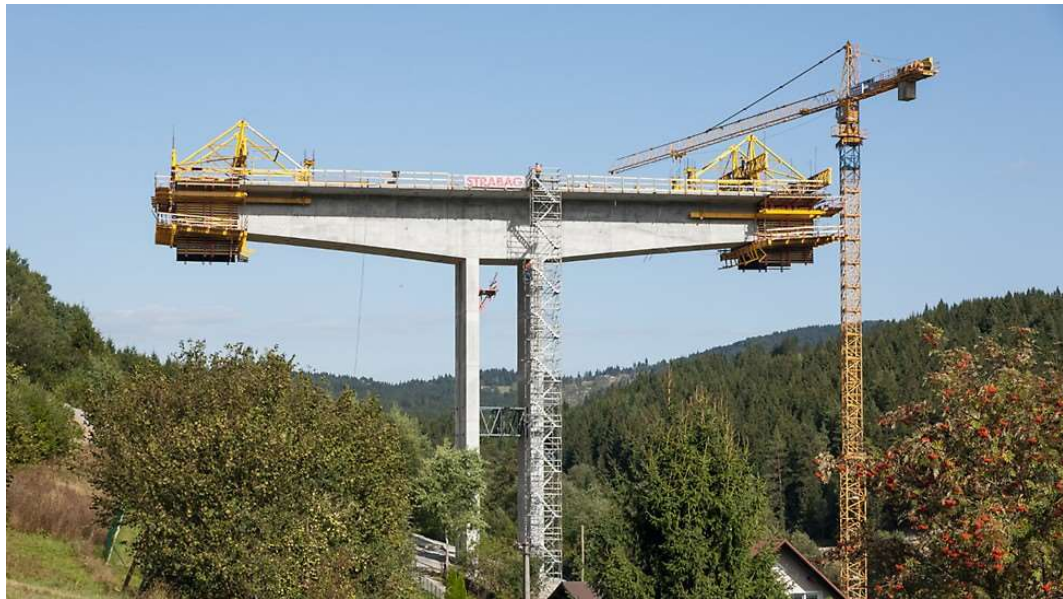
Obr. č.: 17 – Most Markov, příklad letmé betonáže (Zdroj: [3])
