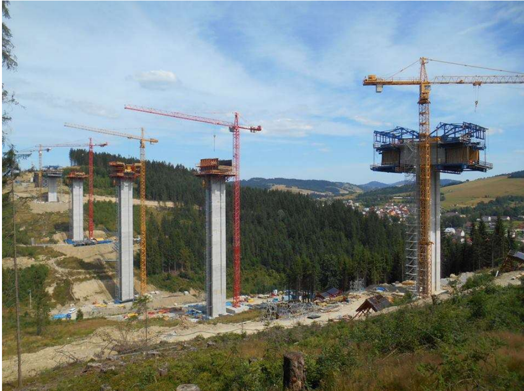
Obr. č.: 24 Most Valy, hotová betonáž zárodků, na zárodku vpravo osazeny betonářské vozíky (Zdroj: [8])
