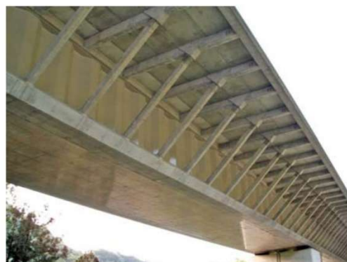
Obr. č.: 28 – Vzpěry podírající chodník – japonský most „Katsurashima Viaduct“ [10]
