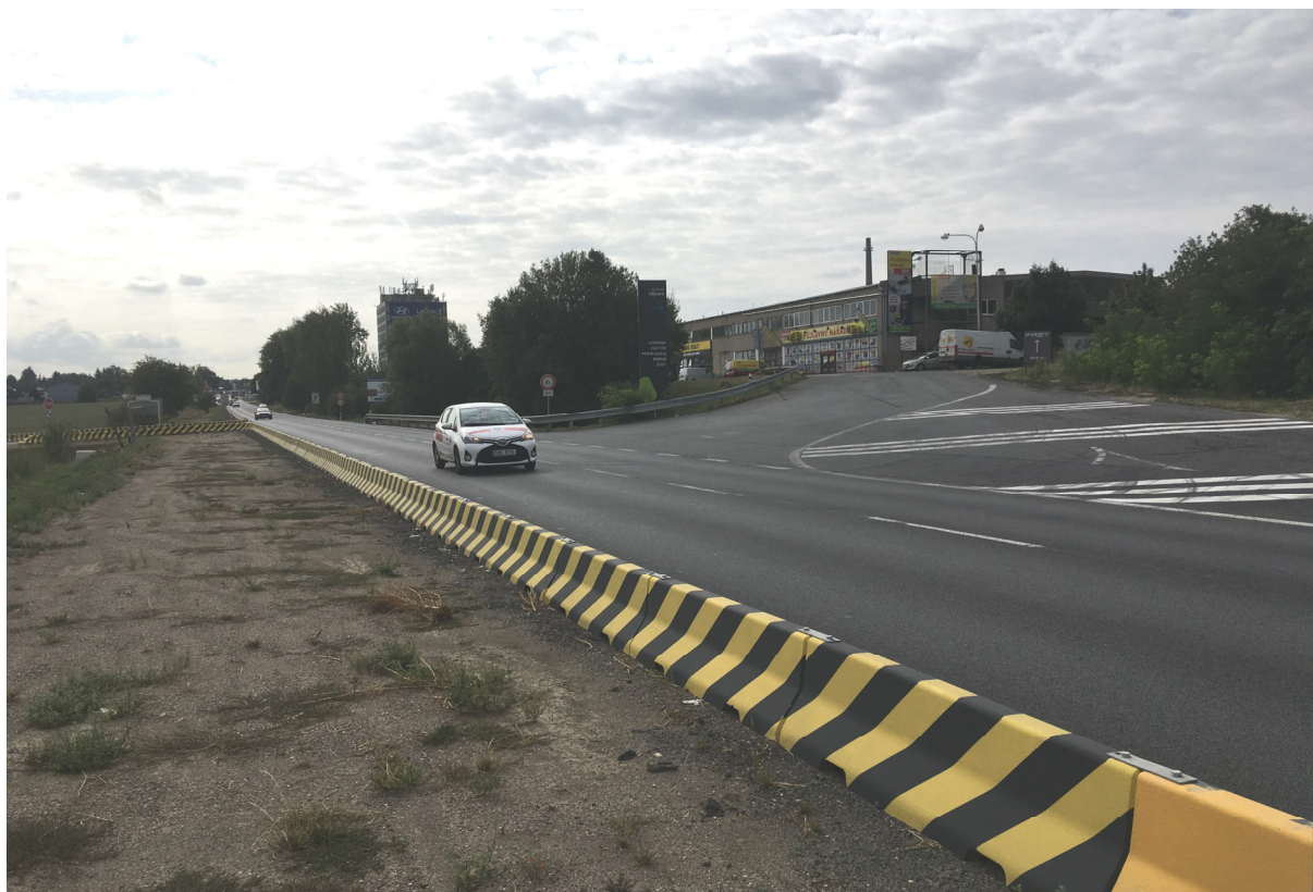
Obrázek 19: I/2 směr Říčany, vjezd do průmyslového areálu Černokostecká, OK západ
