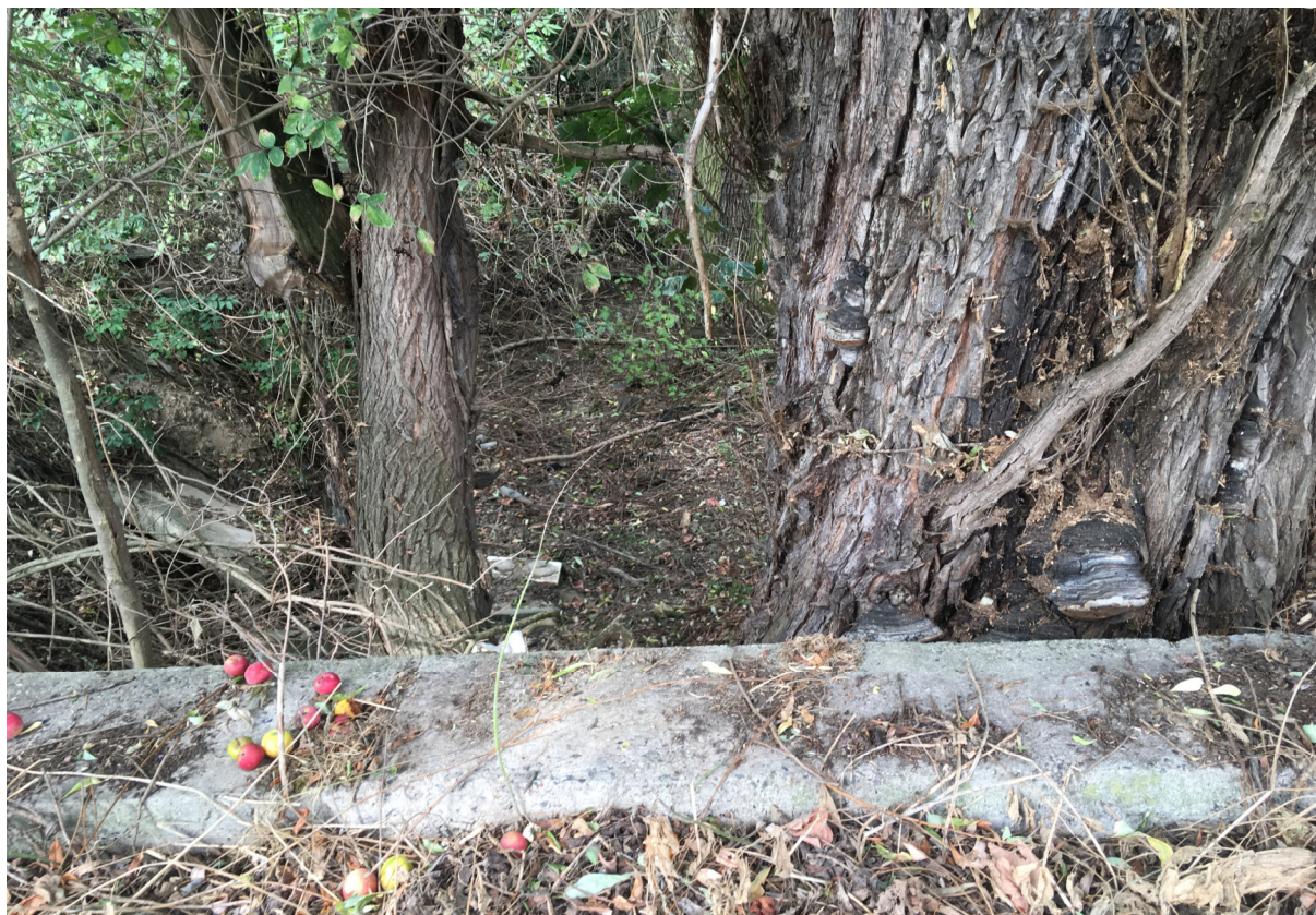
Obrázek 9: Koryto Pacovského potoka v místě přemostění, most 1
