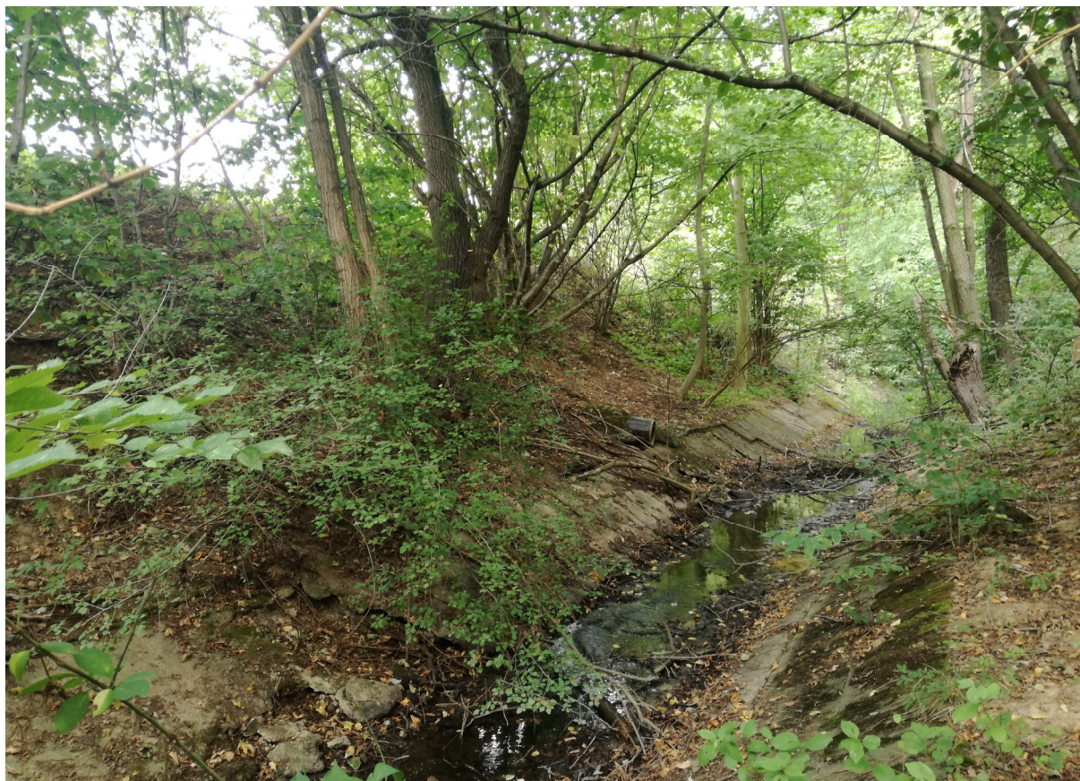
Obrázek 13: Koryto potoku Rokytká, most 2
