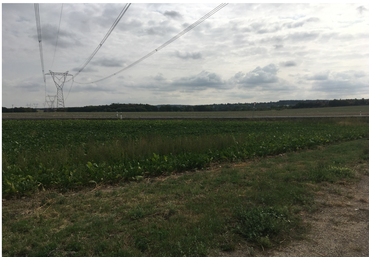
Obrázek 16: Pohled od KÚ hlavní trasy směrem budoucího vedení hlavní trasy
