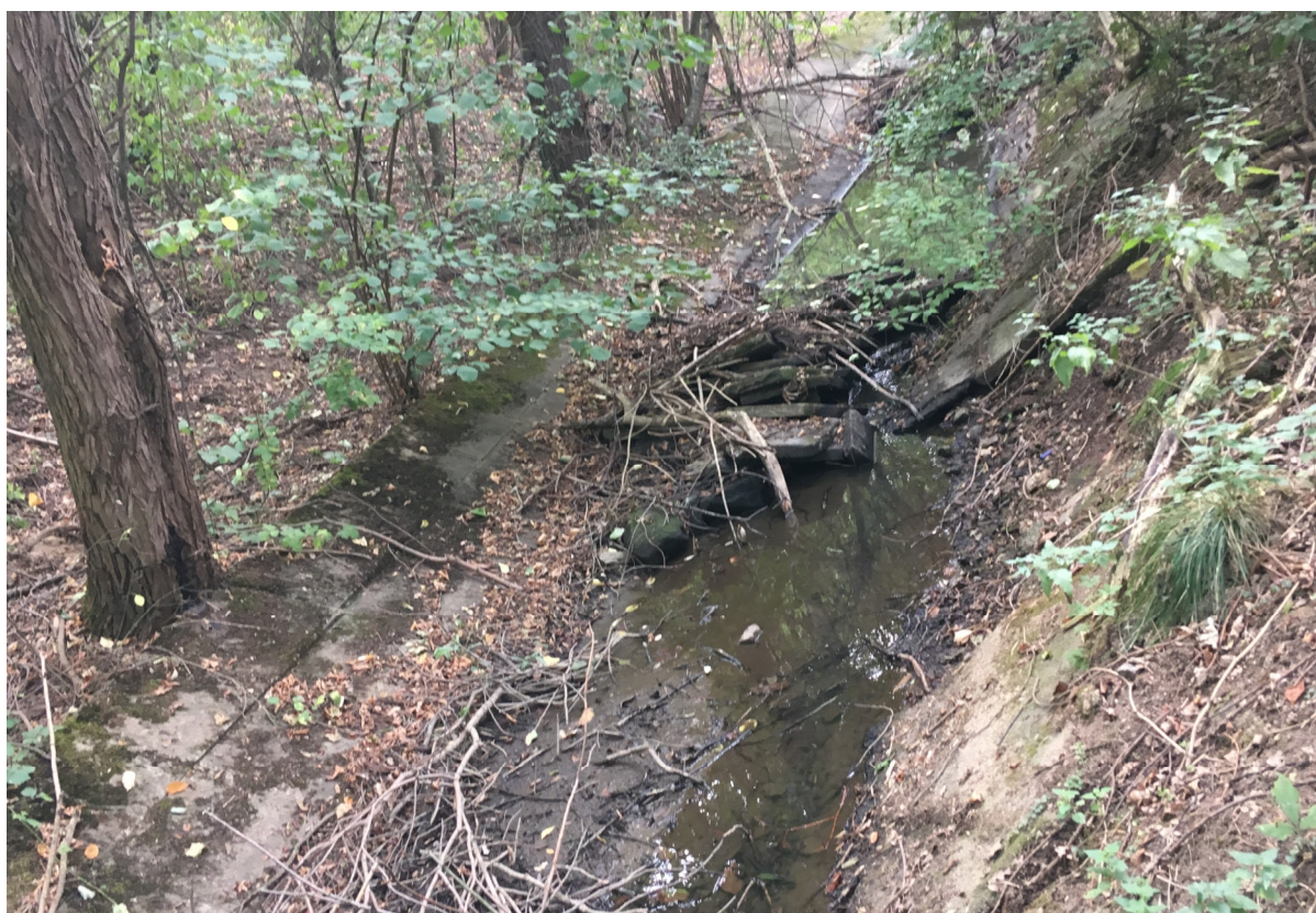
Obrázek 12: Koryto potoku Rokytka, most 2
