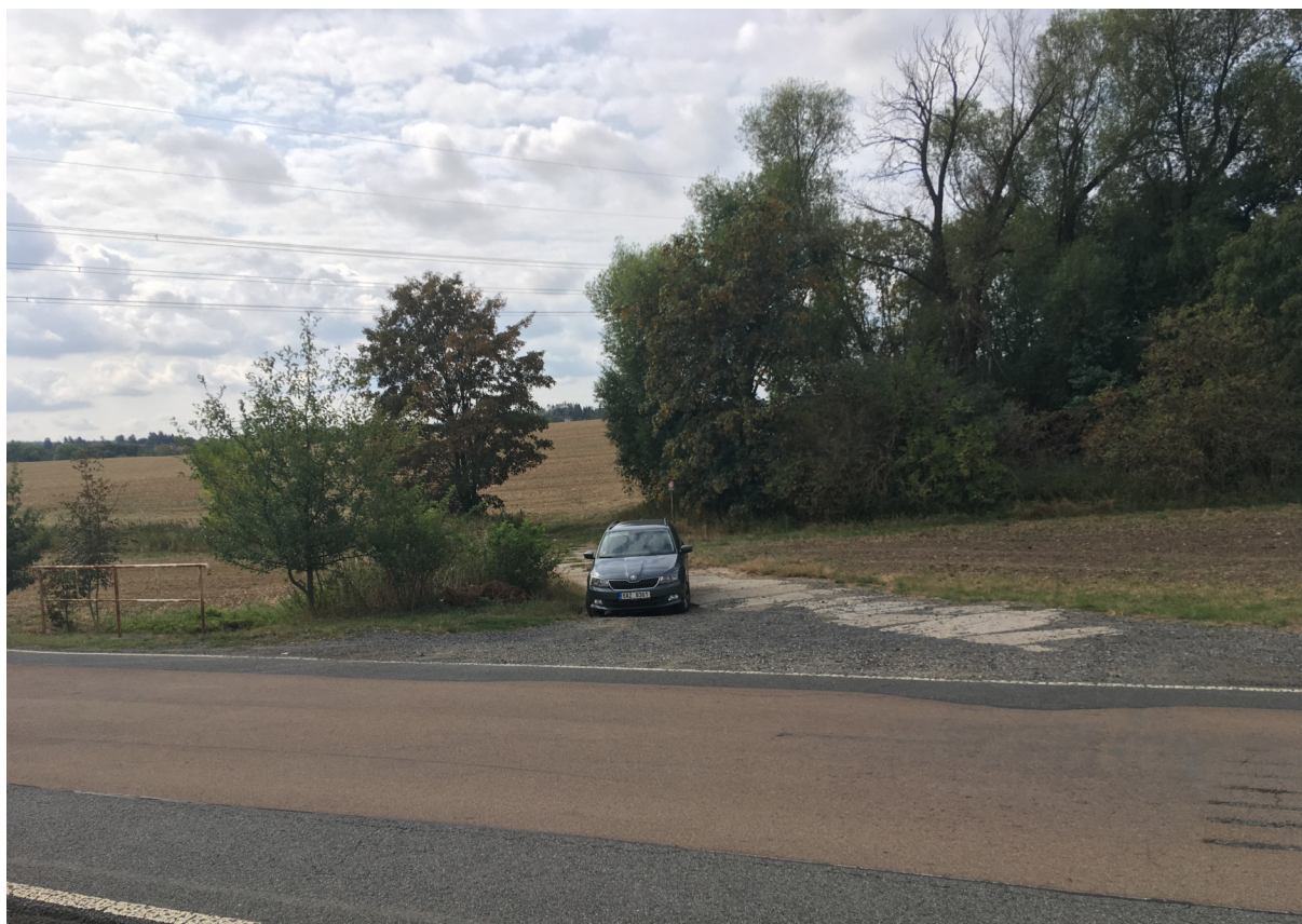
Obrázek 7: Pohled na místo přemostění ulice Mírová a Pacovského potoka, most 1
