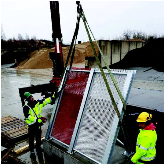
Obrázek 49-Manipulace pomocí úvazků [Vlastní zdroj]
