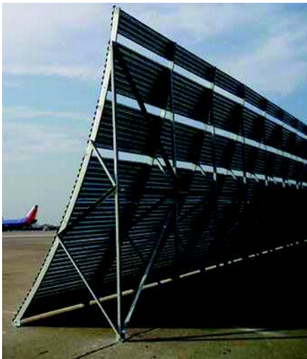
Obrázek 17-Zadní pohled na deflektor z řady TAXI POWER [7]
