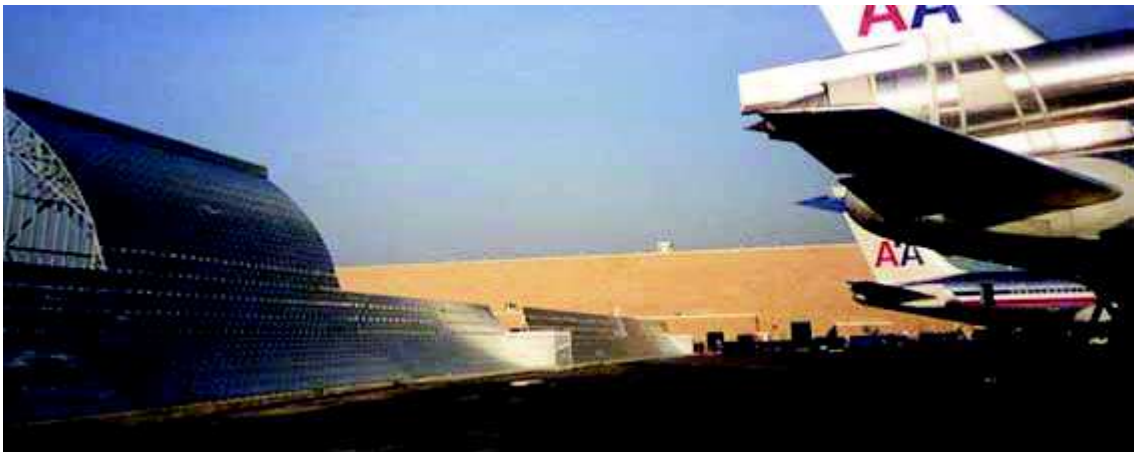
Obrázek 19-Konstrukce deflektoru ze série HIGH POWER odolávající maximálnímu zatížení výtokovými plyny [7]
