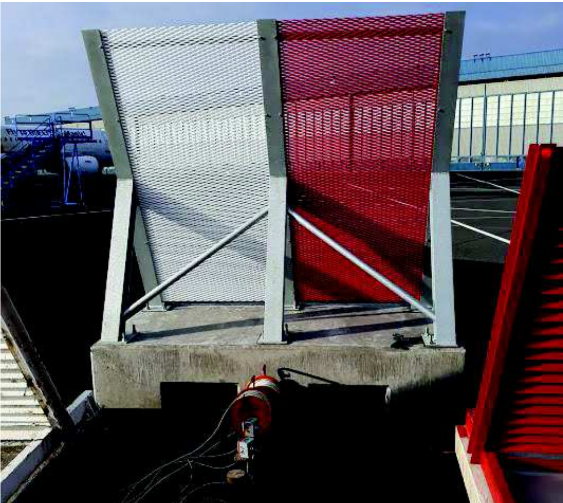
Instalace strunových tenzometrů měřících průhyb tahokovu ve dvou místech
