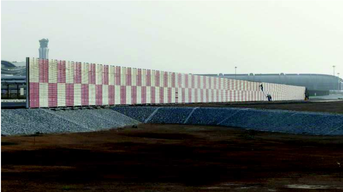
Obrázek 29-Další příklad konstrukce plotového deflektoru od firmy Blast-Ex [10]
