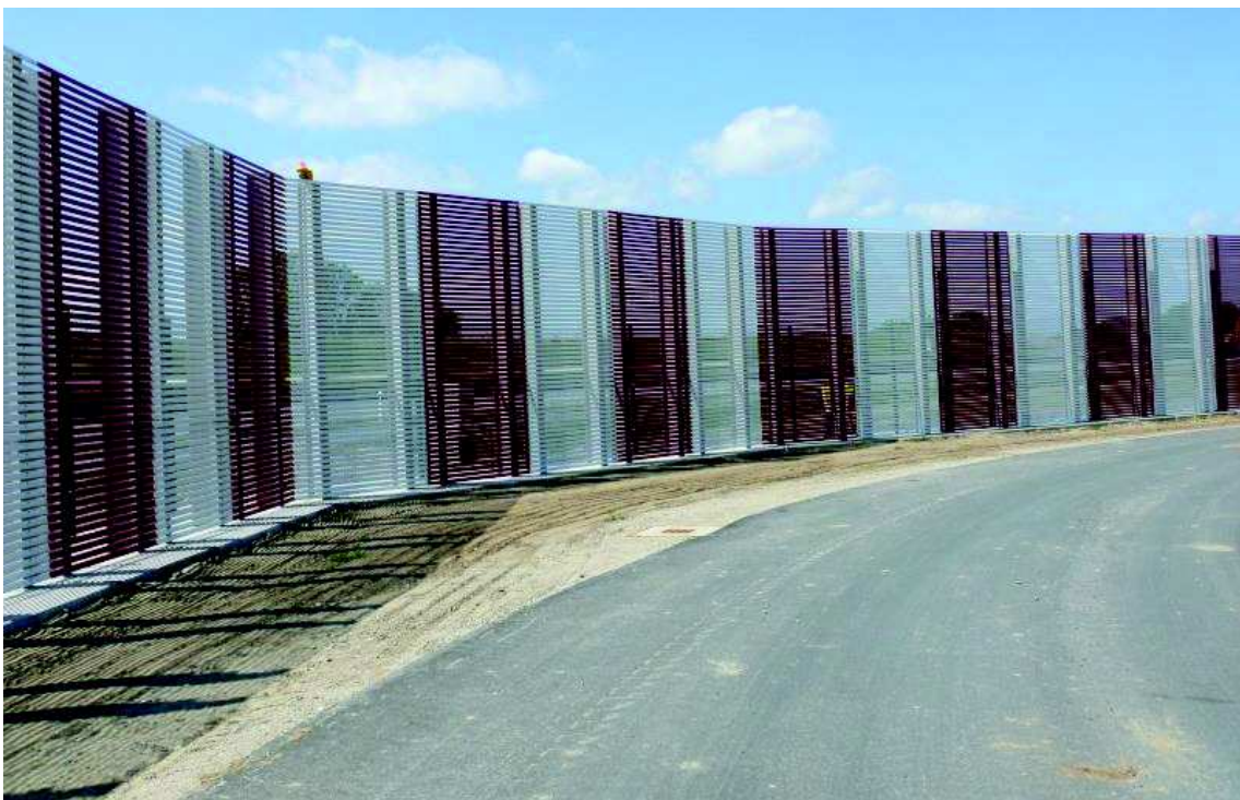
Obrázek 30-Dokončení montáže deflektorů na jednom z úseků mezinárodního letiště v Muscatu [10]
