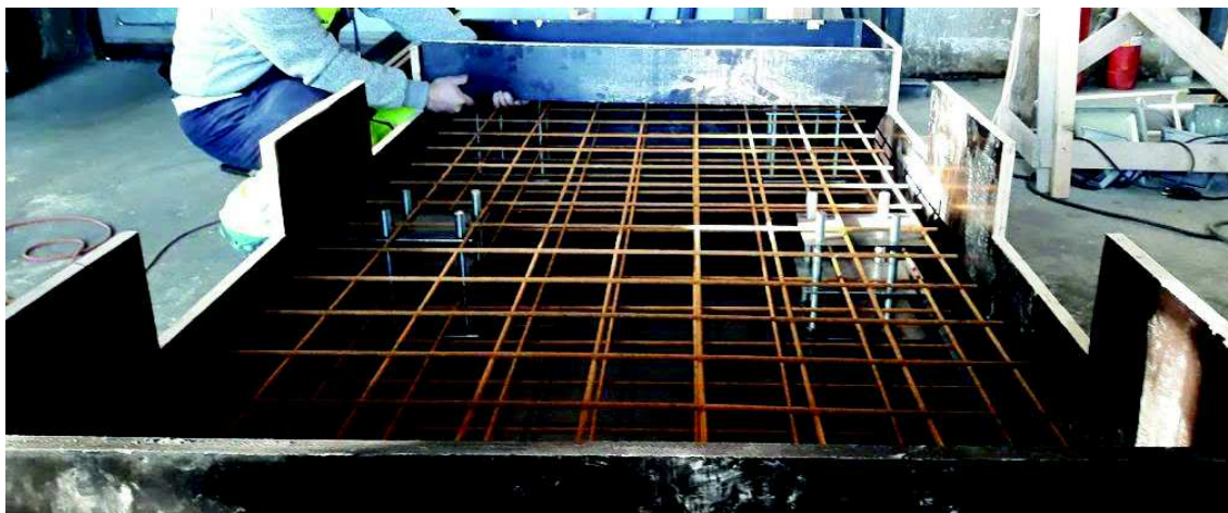
Obrázek 54-Rozmístění výztuže bloku
