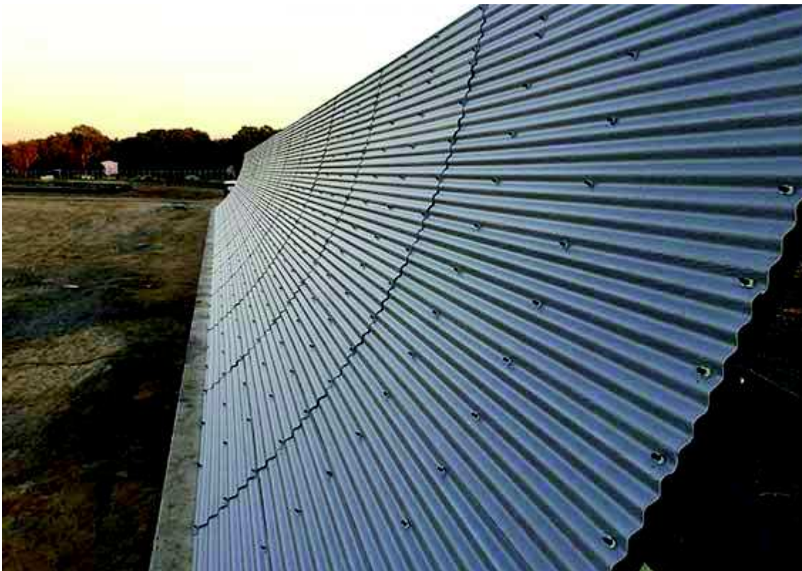
Obrázek 16- Příklad konstrukce kotveného deflektoru ze série FIBERGLASS [7]
