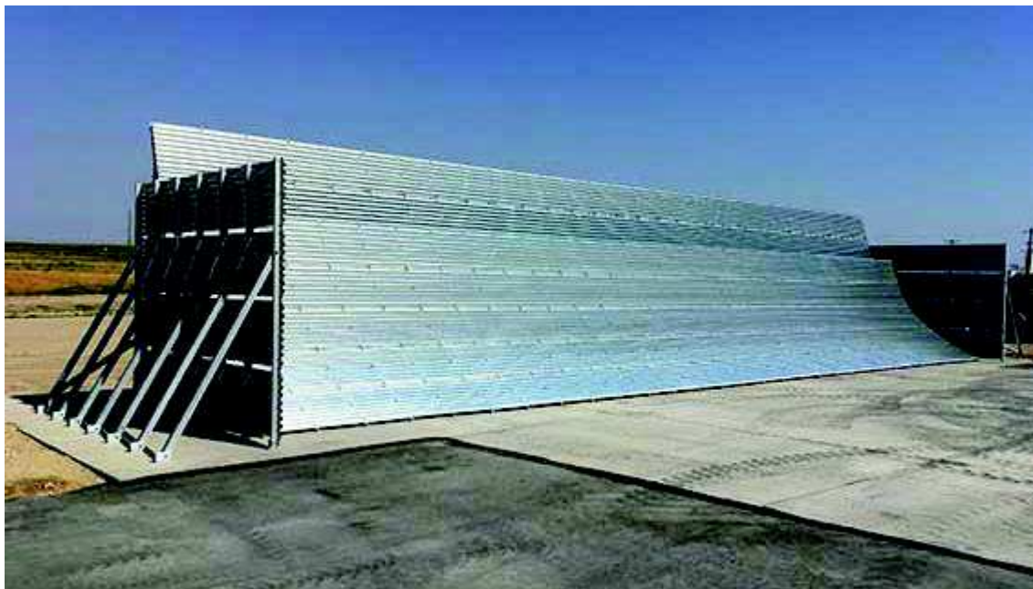
Obrázek 15-Příklad konstrukce kotveného deflektoru z řady Ocelová série [7]
