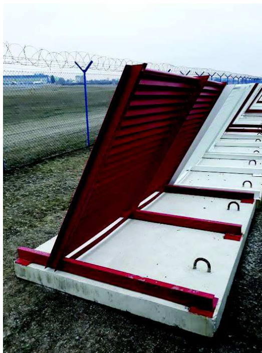
Obrázek 41- Nové deflektory vyrobené podle starých konstrukcí [Vlastní zdroj]
