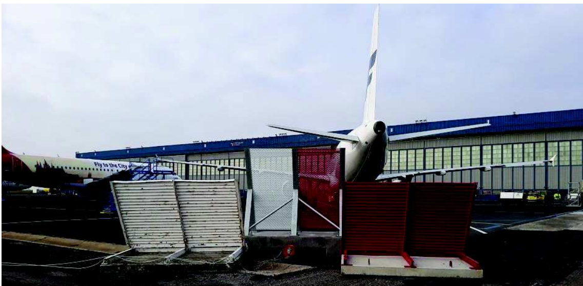
Nový odražeč je umístěn přímo v ose motoru, tak aby byl vystaven největšímu zatížení výtakovými plyny
