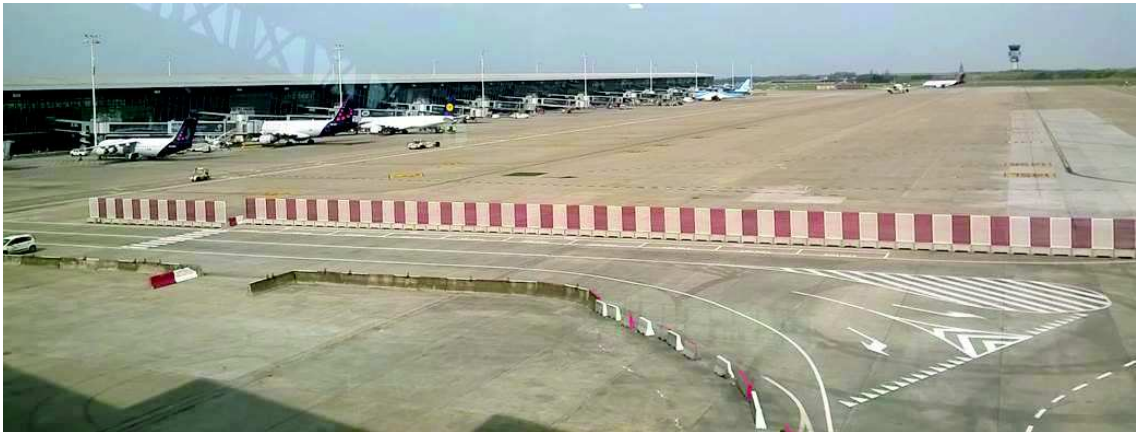
Obrázek 2-Umístění deflektorů podél obslužné komunikace u stání letadel na letišti v Bruselu [Vlastní zdroj]
