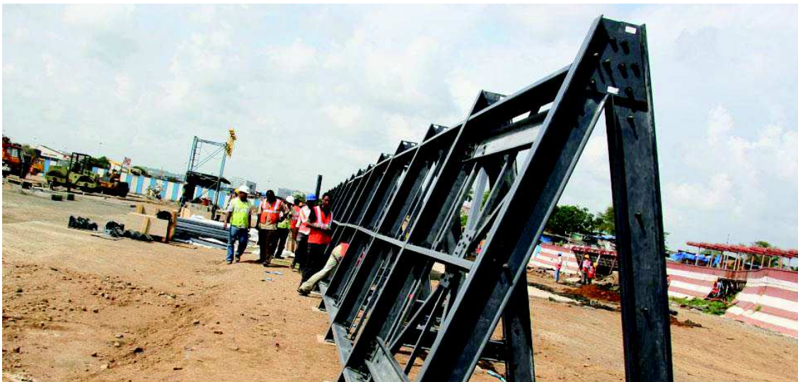
Obrázek 22-Montáž sklolaminátové Blastwall konstrukce na mezinárodním letišti Chattrapati Shivaji v Bombaji [8]
