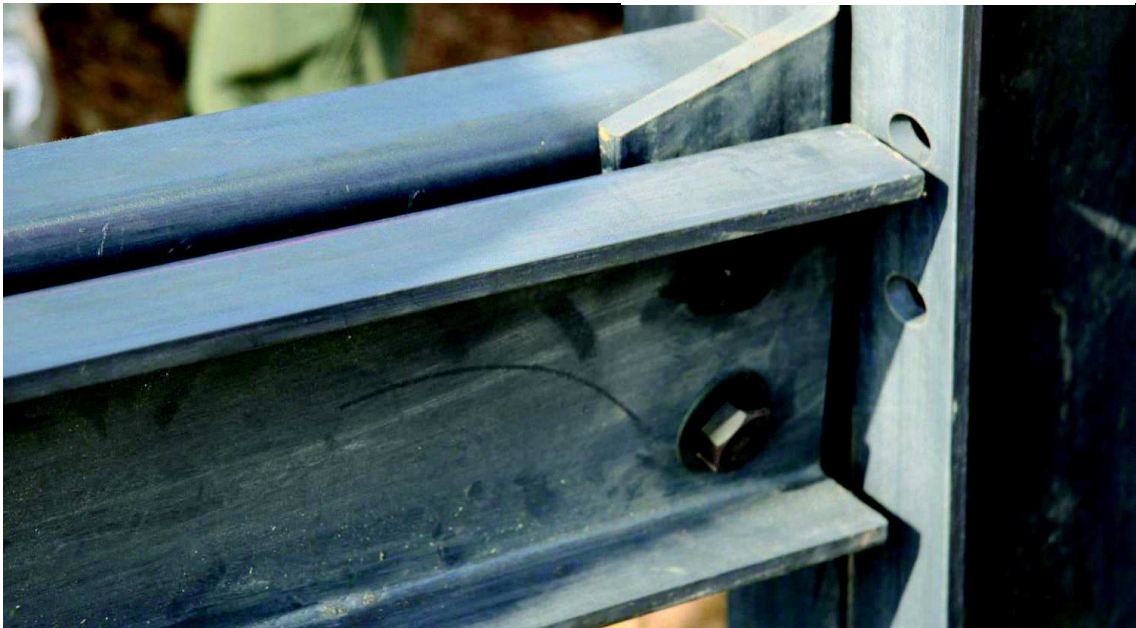
Obrázek 23- Boční stabilizační nosník vyrobený ze sklolaminátových vláken [8]
