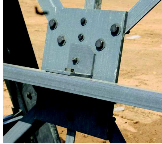
Obrázek 24- Centrální styčkový plech pro stabilizaci [8]
