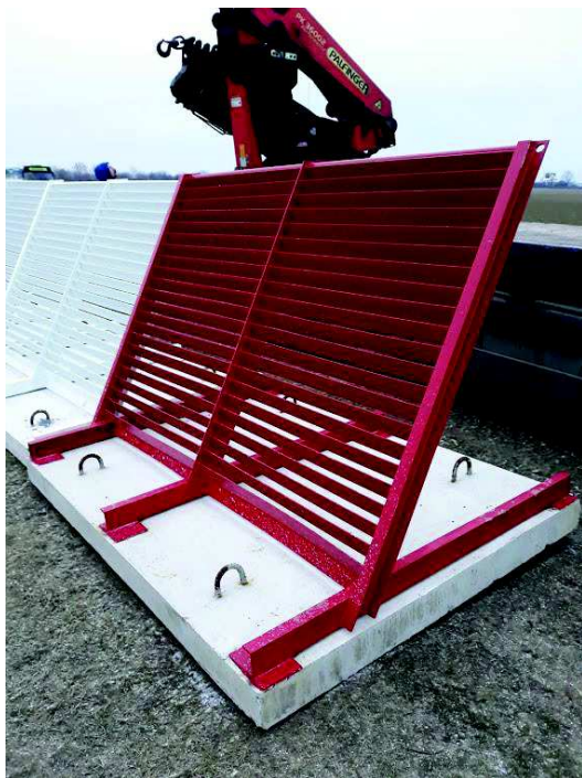
Obrázek 40-Nové deflektory vyrobené podle starých konstrukcí [Vlastní zdroj]
