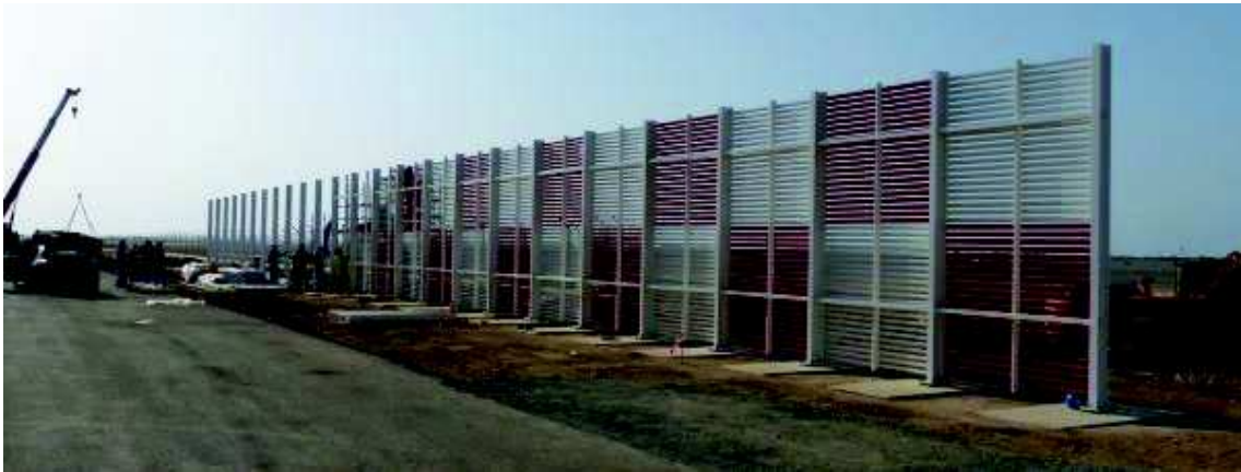
Obrázek 27-Montáž nových deflektorů na mezinárodním letišti v Muscatu [10]
