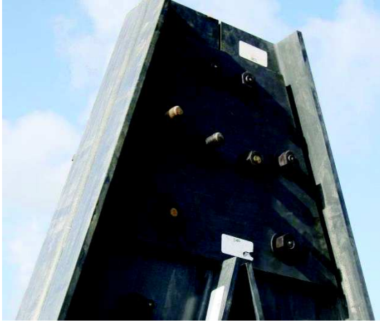
Obrázek 26- Montáž horní rámové desky [8]
