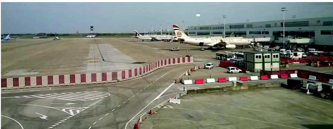
Obrázek 3-Umístění deflektorů podél obslužné komunikace u stání letadel na letišti v Bruselu [Vlastní zdroj]
