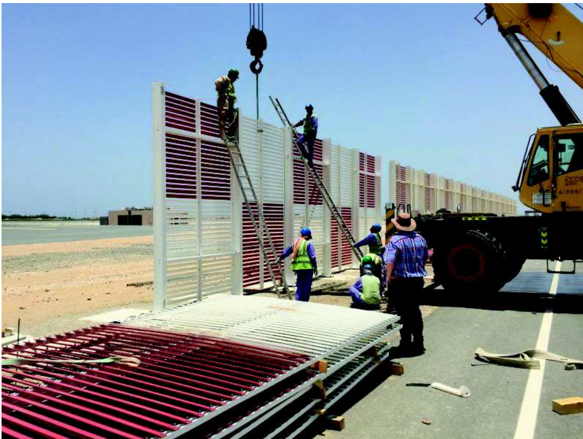
Obrázek 28-Montáž nových deflektorů na mezinárodním letišti v Muscatu [10]
