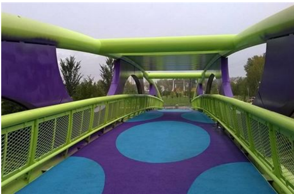
Obr. 11: Lávka v Karlových Varech [10]
