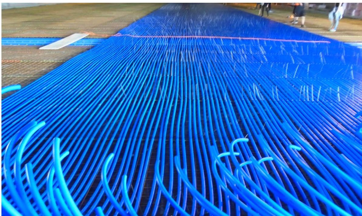
Obrázek č. 28 – Fotografie: trubní vedení - vlásenky, Zdroj: PD
