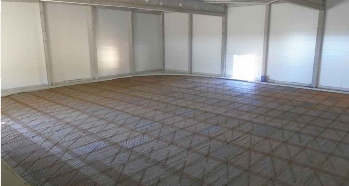
Obrázek č. 16 – Fotografie: vyztužení vyhřívané desky, Zdroj: PD
