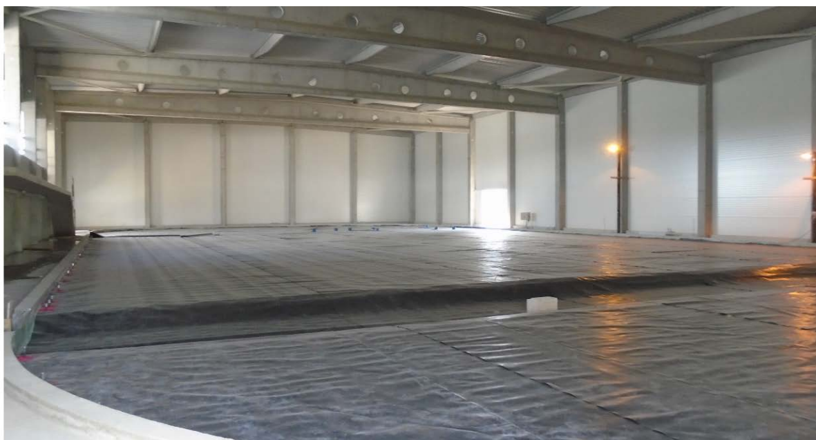
Obrázek č. 20 – Fotografie: Vyhotovené izolačních vrstvy Zdroj: PD
