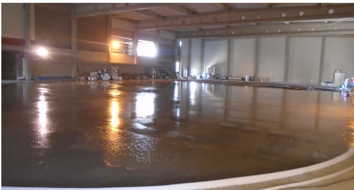
Obrázek č. 31 – Fotografie: Čerstvá betonová deska, Zdroj: PD
