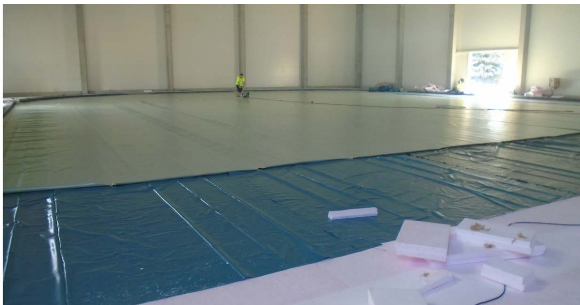
Obrázek č. 19 – Fotografie: realizace izolačních vrstev Zdroj: PD
