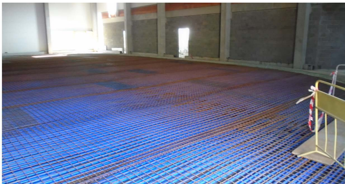
Obrázek č. 30 – Fotografie: ledová plocha připravená k betonáži, Zdroj: PD
