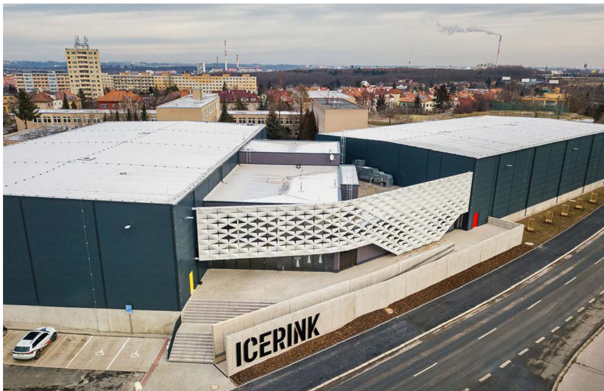
Obrázek č. 4 – fotografie: exteriér, pohled z výšky (1)
