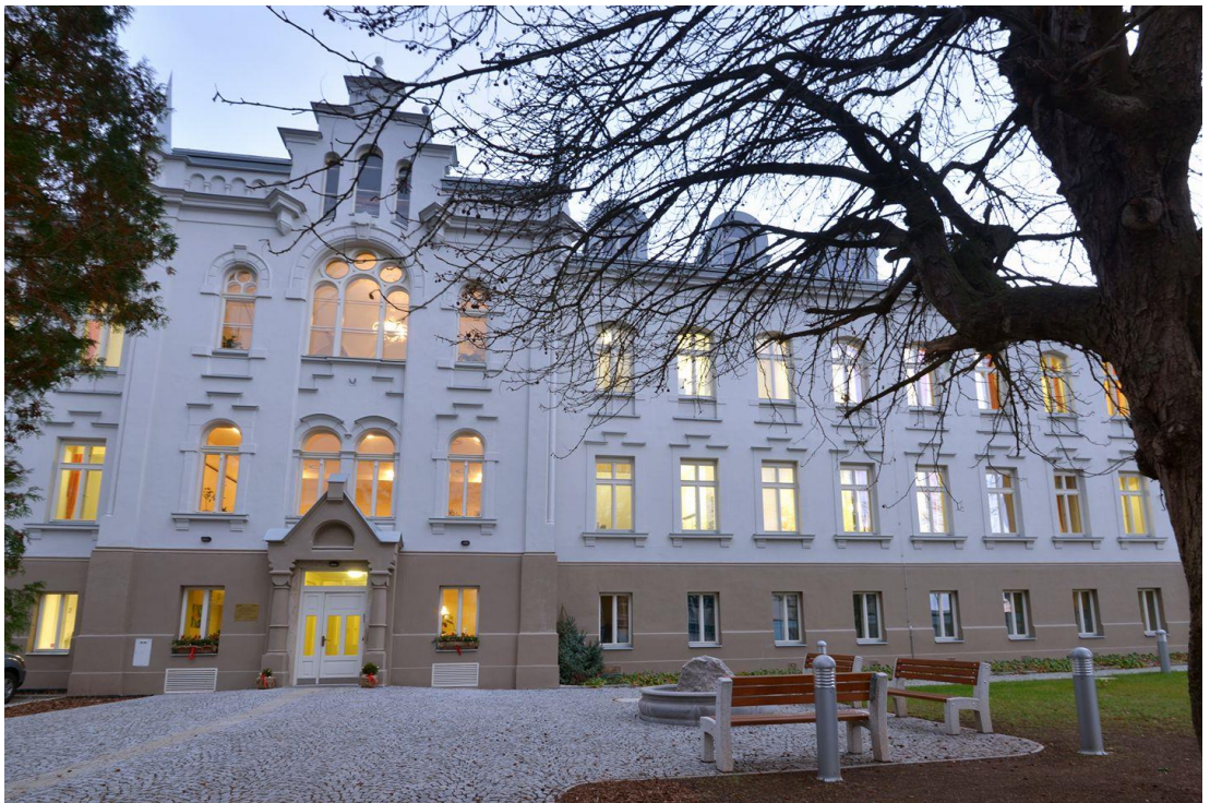
Obr. 2 zrekonstruovaný objekt hospice (zdroj www.hospiczdislavy.cz )
