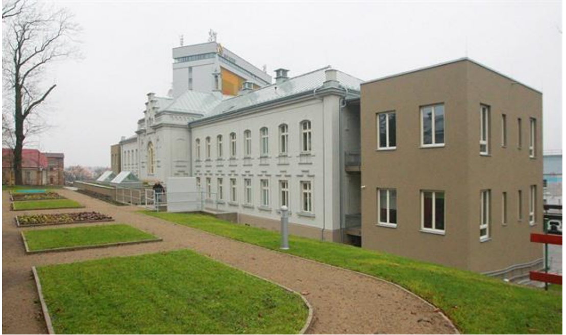
Obr. 1 zrekonstruovaný objekt hospice (zdroj www.hospiczdislavy.cz )
