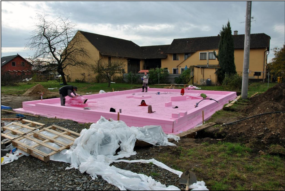
Obr. 4: Zakládání staveb na XPS (převzato z [13])
