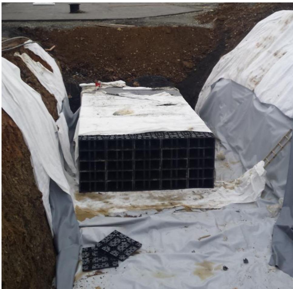
Obr. č. 1: Retenční objekt
