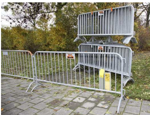
Obrázek 46: Zábradlí pro ohrazení výkopu
