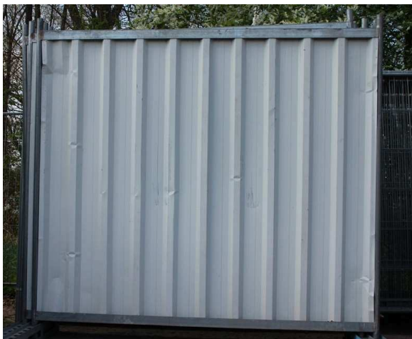
Obrázek 45: Plotové dílce pro oplocení staveniště
