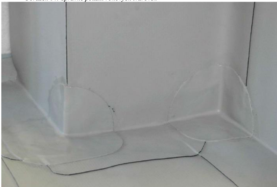
Obrázek 64: Správné použití rohových tvarovek
