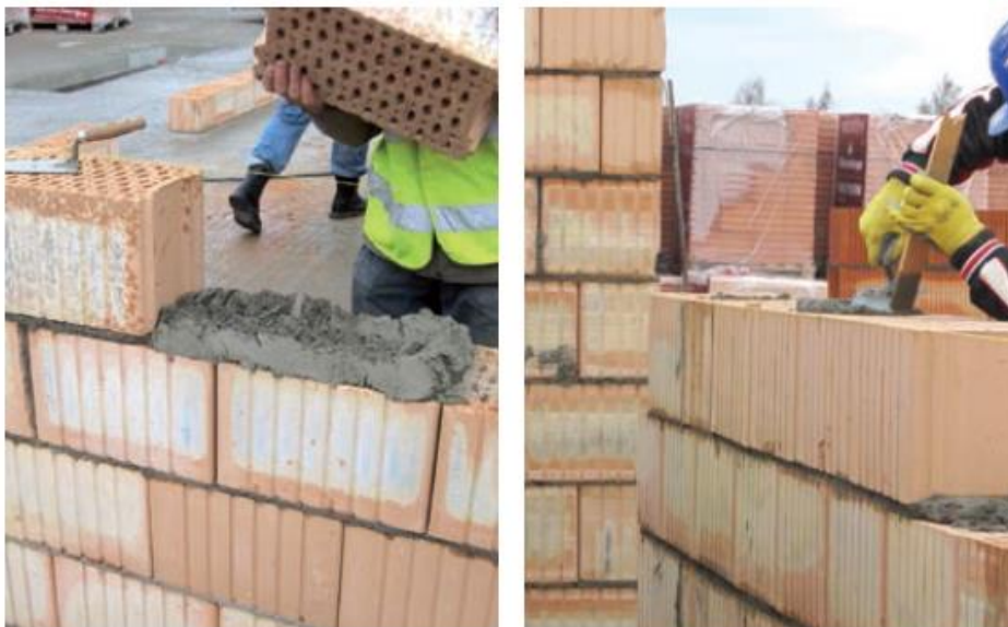
Obrázek 26: Převazba cihelných bloků POROTHERM
