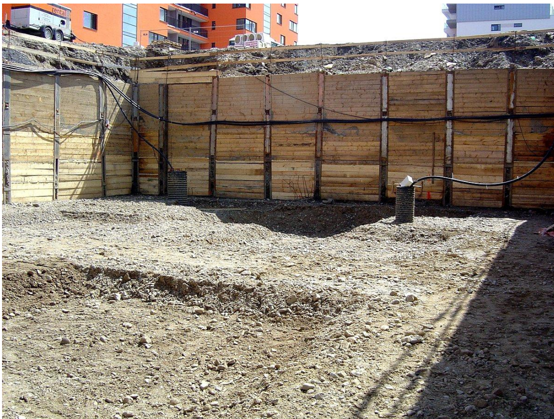
Obrázek 30: Zajištění stavební jámy Zdroj: cenekajezeck [online]. [cit. 2018-11-08]. Dostupné z: http://www.cenekajezeck.cz/zaporove-pazeni-1
