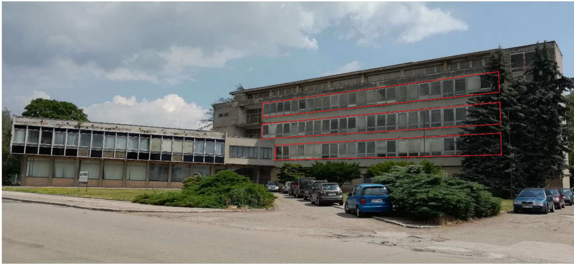
obr. 5 – Fotografie stávajícího stavu se zvýrazněnými pásovými okny
