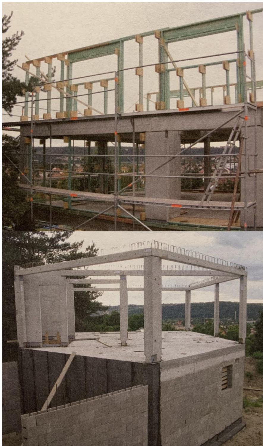
Obrázek 7 – Průběh stavby domu T, převzato z [17]
