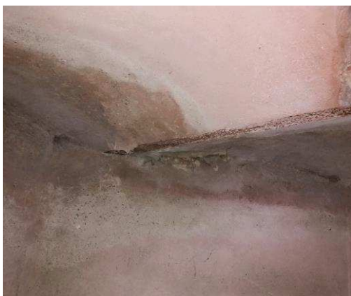
Obrázek 19 - Projevy zatékání srážkové vody z ochozu na věži na vnitřních konstrukcích
