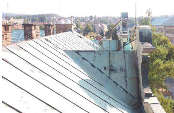
Obrázek 11 – Pohled z věžičky na střechu východního křídla
