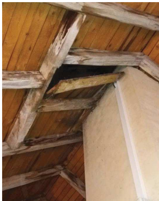
Obrázek 47 - Porušená část stávajícího bednění
