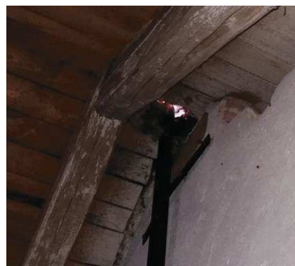
Obrázek 12 – Otvory ve střešním pláště
