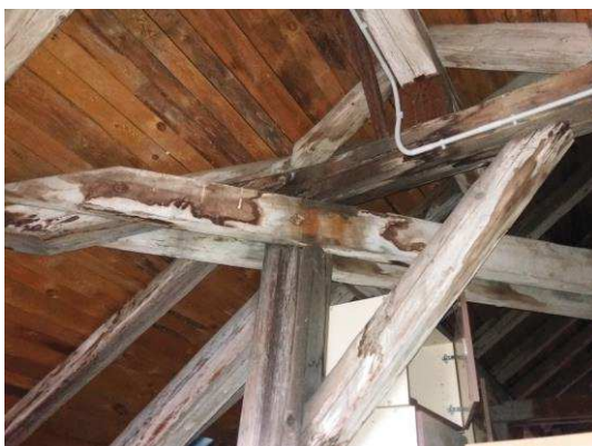
Obrázek 15 - Projevy zatékání do objektu na dřevěných prvcích
