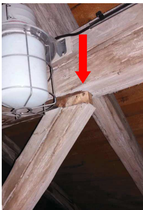
Obrázek 36 - Porucha spoje pásek - vaznice
