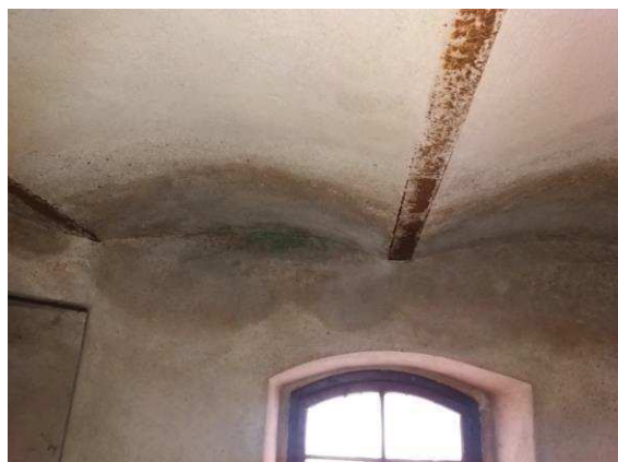
Obrázek 19 - Projevy zatékání srážkové vody z ochozu na věži na vnitřních konstrukcích
