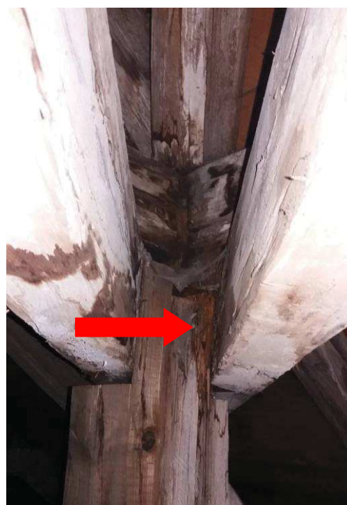
Obrázek 37 - Porucha spoje kleštiny - sloup
