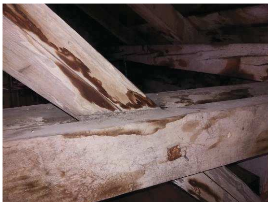
Obrázek 15 - Projevy zatékání do objektu na dřevěných prvcích
