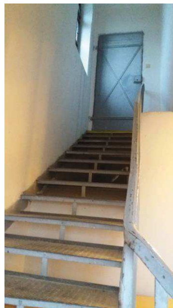
Obrázek 7 - Schodiště do podkroví
