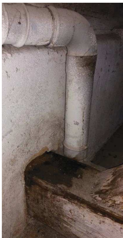
Obrázek 33 - Vlhké zhlaví VT1-B vlivem technických vad
