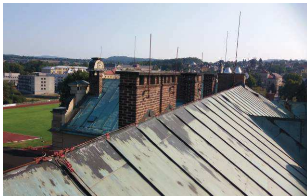
Obrázek 20 – Pohled na střechu - komíny, hromosvod
