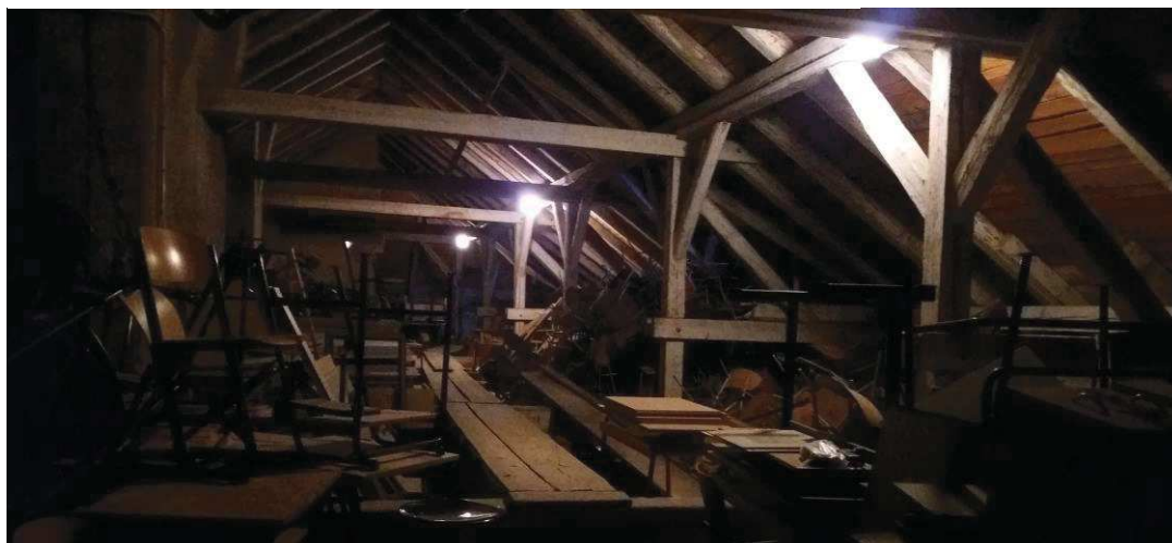
Obrázek 16 - Vaznicová soustava, stojatá stolice
