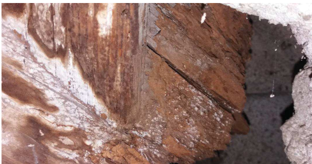
Obrázek 24 - Krokev napadená dřevomorkou domácí, odběr vzorku MV5
