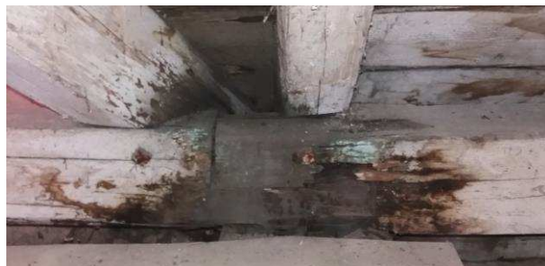
Obrázek 40 – Vaznice napadená dřevokaznou houbou, vzorek MV 3
