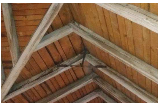
Obrázek 13 – Kovové konstrukční prvky
