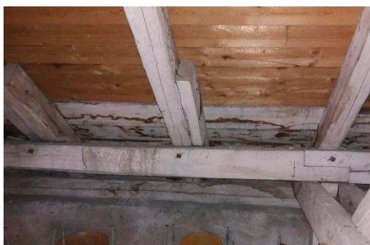
Obrázek 14 – Výměna části záklopu
