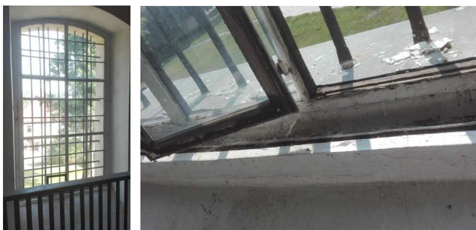
Obr. č. 39.; 40. velké okno levé oratoře; detail žlábků na kondenzát
