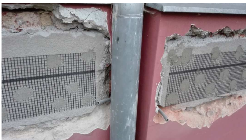
Obr. č. 90. osazená anoda s rozšiřující síťovinou a připravena průchodka pro spojovací vodič, foto z instalace firmy Prins na domě v ul. V Cibulkách 358/54 - Košře
