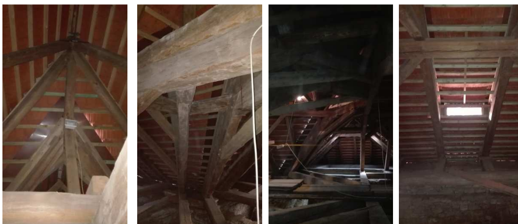
Obr. č. 63.; 64.; 65.; 66. vazba u změny výšky hřebene mezi hl. lodí a presbytářem; dvojice plných vazeb propojující krov presbytáře a hl. lodi; spojení krovů z boku; střešní okno
