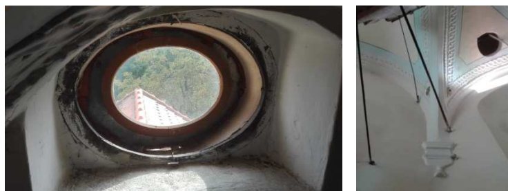
Obr. č. 27.; 28. oválné okno v čele presbytáře; zdobné zakončení žebra klenby
