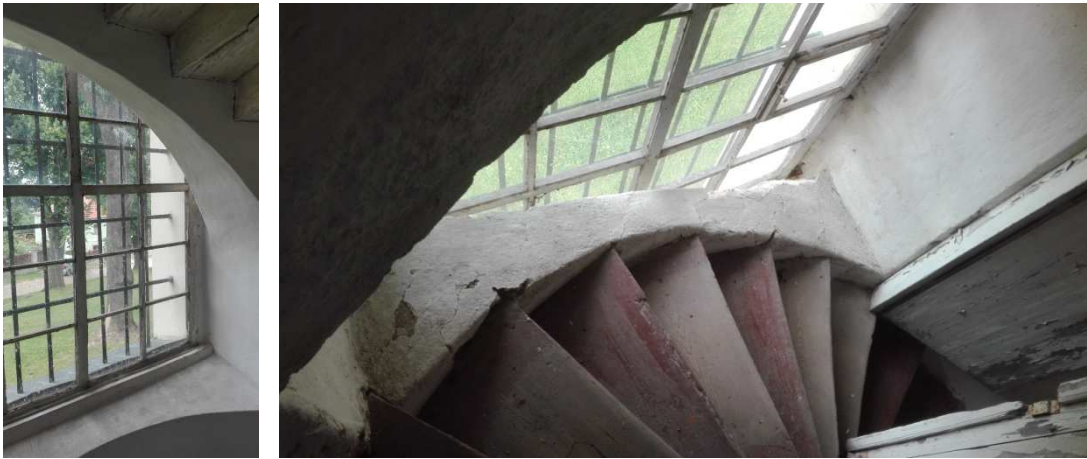
Obr. č. 47.; 48. parapet velkého okna na schodišti; schodnice podpírající stupně před oknem
