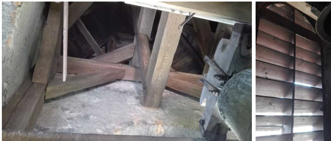
Obr. č. 53.; 54. zapuštění "křížového" trámů do zdi a čtvercová stolice; žaluziové okno zvonice
