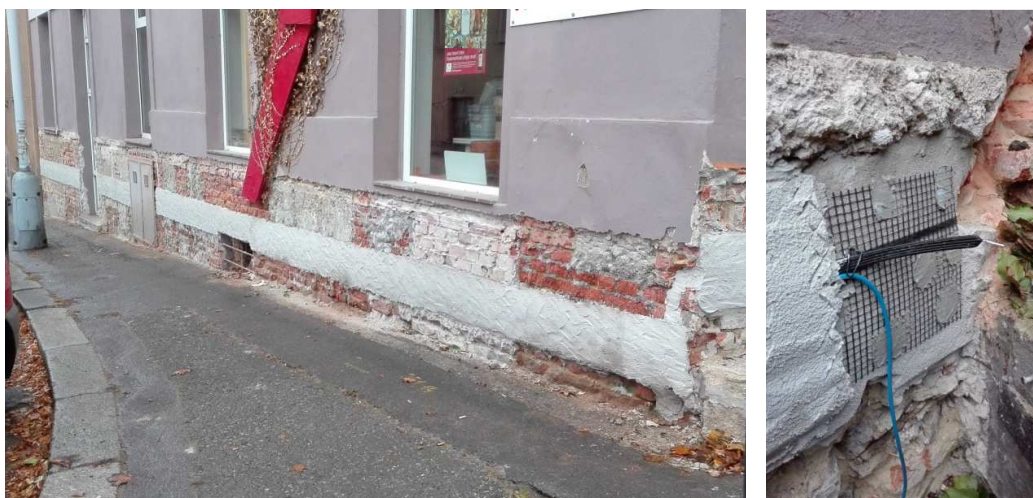
Obr. č. 91.; 92. překrytá anoda maltou se zvýšenou vodivostí; připravené zakončení anody na propojení s anodou o etáž výš, modrý propojovací kabel vedoucí ke katodě, foto z instalace firmy Prins na domě v ul. Slávy Horníka 39 - Košiče
