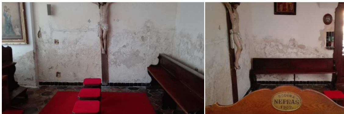
Obr. č. 21.; 22. jižní stěna pod kruchtou; věžní západní stěna
