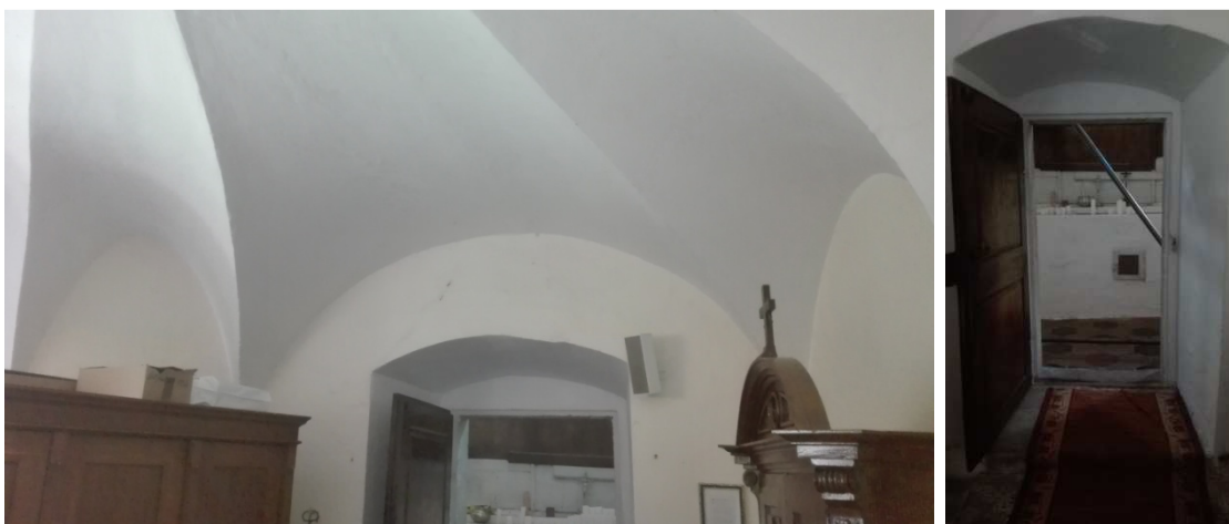
Obr. č. 33.; 34. zaklenutí od šikmých stěn; vstup z lodi kostela
