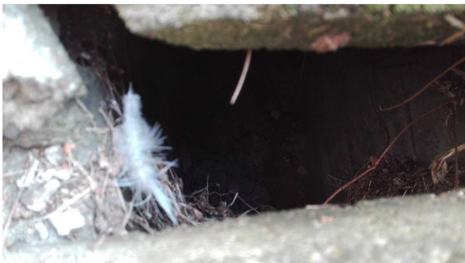
Obr. č. 85. pohled úzkou propadlinou do žlabu na jižní straně, patrný stejný styl jako v severní části a vrstva nečistot na dně.
