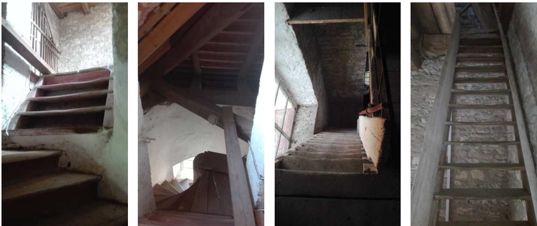
Obr. č. 49.; 50.; 51.; 52. malé schodiště do věže; ukončení točitého schodiště; pohled z 2. patra věže do prvního; schody do patra ke zvonu
