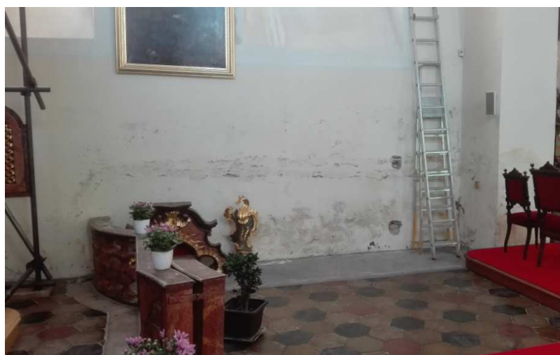
Obr. č. 32. jižní stěna presbytáře (vedle žebříku odběrné výseky pro vázkovou metodu)
