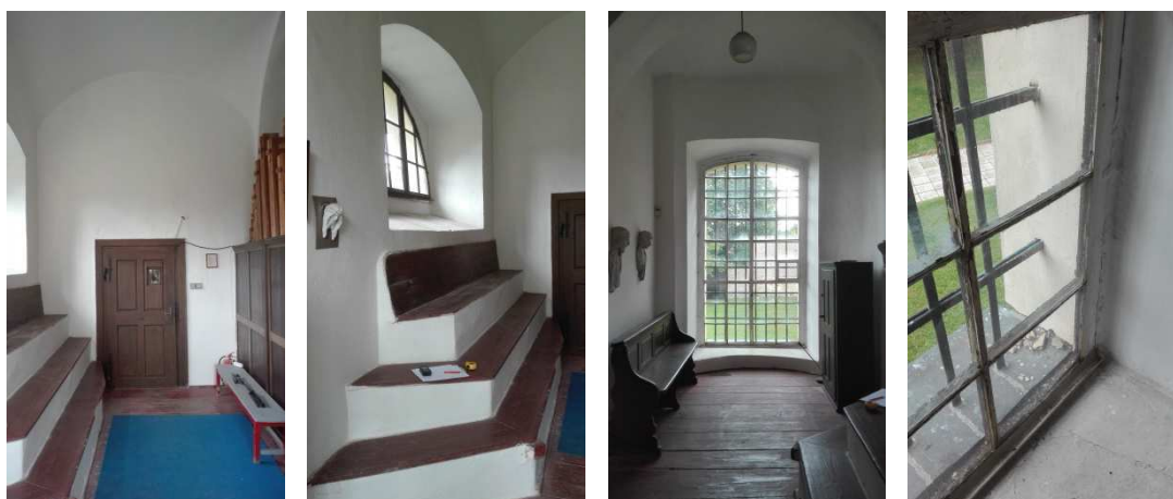
Obr. č. 55.; 56.; 57.; 58. vstupní dveře na kůr; půlkruhové okno s lavicemi; velké okno; osazený kanálek na kondenzát
