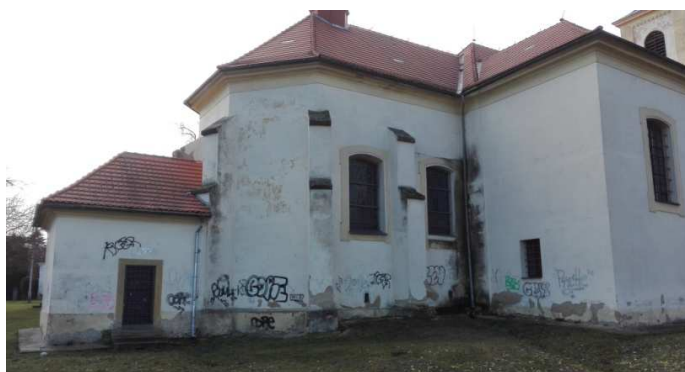
Obr. č. 16. severní fasáda sakristie a presbytáře s levou oratoří
