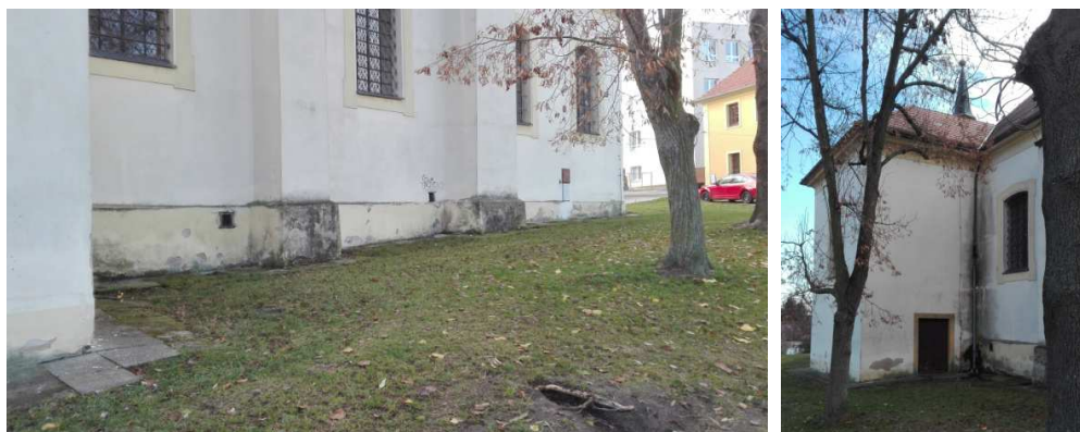
Obr č. 17.;18. severní fasáda hl. lodi; roh severní fasády hl. lodi a levé oratoře
