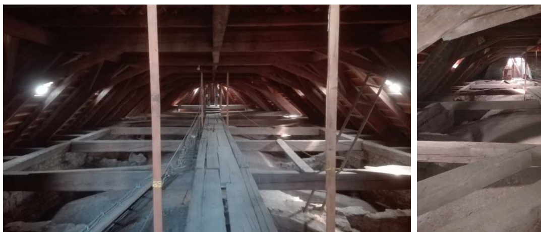
Obr. č. 61.; 62. pohled do krovu od vstupu; pohled od presbytáře
