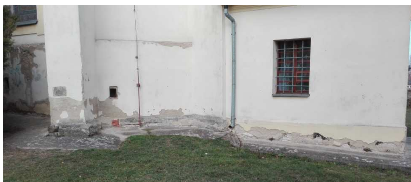
Obr. č. 15. jižní fasáda sakristie
