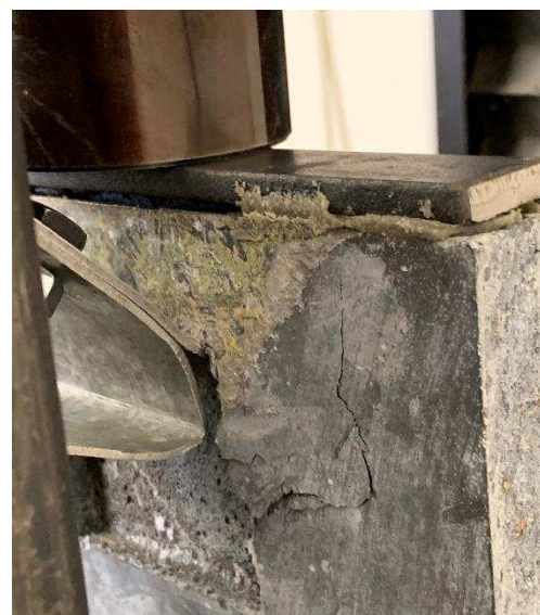
Obr. 72: Následný rozvoj trhlin
