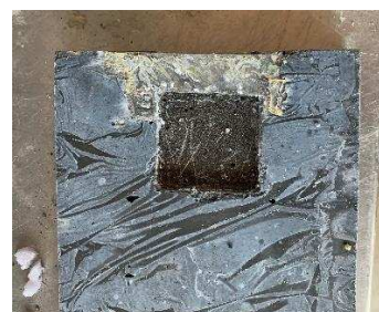
Obr. 51: Po odstranění polystyrenu
