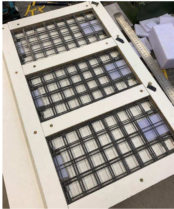
Obr. 39: Desky připravené k betonáži – Varianta A
