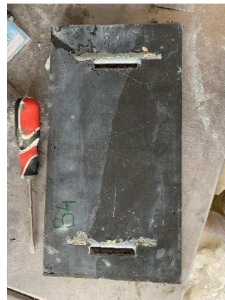
Obr. 49: Po odstranění polystyrenu
