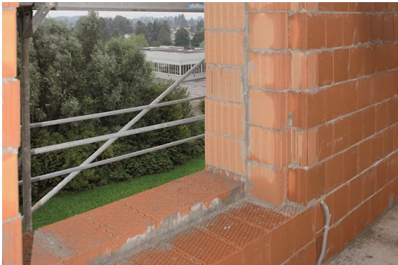
Obr. 9: Ostění a parapet v obvodové stěně [5]
