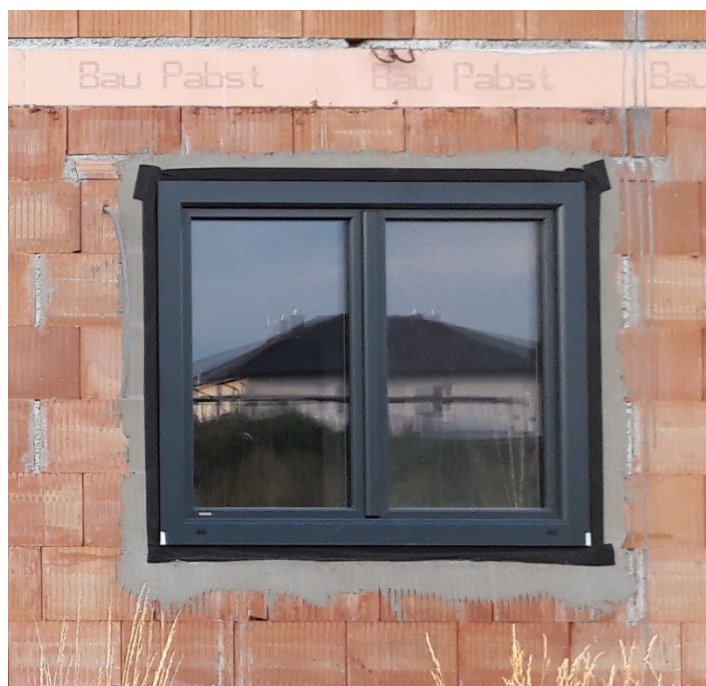
Obrázek 1 – Klasická montáž oken, schématický detail (vlevo), pohled na fasádu (vpravo) [Foto: autor]
