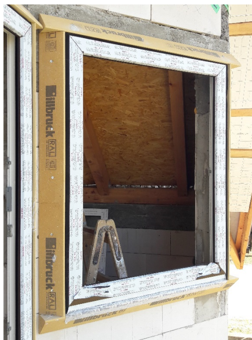
Obrázek 2 - Předsazená montáž oken, schématický detail (vlevo), pohled na fasádu (vpravo) [Foto: autor]
