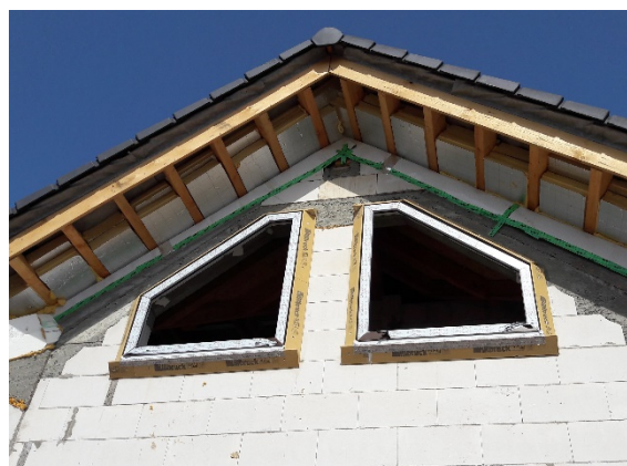
Obrázek 10 - Aplikace komprimační pásky (vlevo), osazené okenní rámy (vpravo) [Foto: autor]
