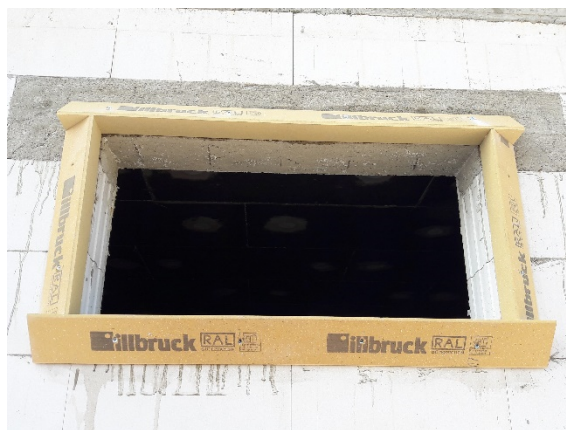
Obrázek 9 - Příklady vytvoření sekundárního ostění systémem Tremco - IIIbruck [Foto: autor]
