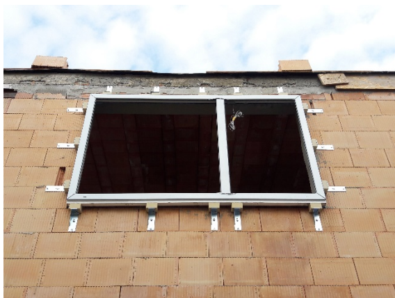
Obrázek 13 - Okenní rám osazený systémem Dafe - Purex - Basic [Foto: autor]
