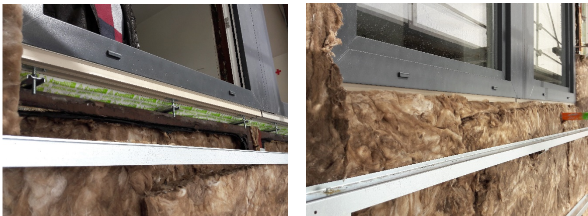
Obrázek 7 - Příklad systémového řešení od firmy SFS Intec, osazená okenní výplň [Foto: autor]
