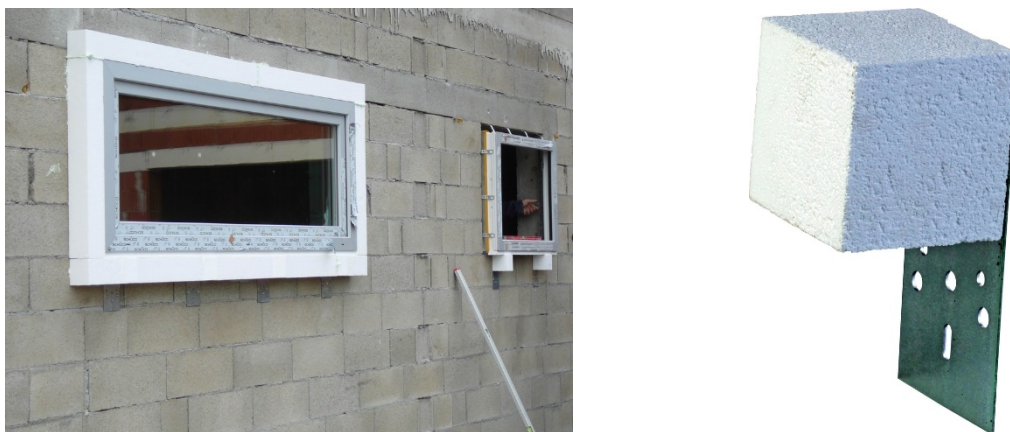
Obrázek 12 - Okna osazená pomocí systému EJOT - Compacfoam (vlevo), upevňovací bod (vpravo) [17]
