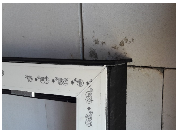
Obrázek 10 - Aplikace komprimační pásky (vlevo), osazené okenní rámy (vpravo) [Foto: autor]
