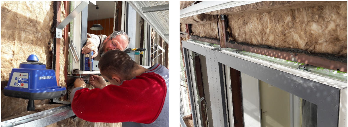
Obrázek 8 - Výšková rektifikace okna (vlevo), osazená okenní výplň (vpravo) [Foto: autor]
