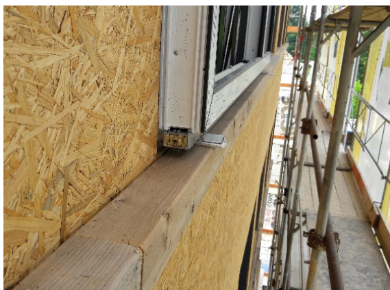
Obrázek 6 - Příklad nevhodného nesystémového řešení předsazené montáže [Foto: autor]
