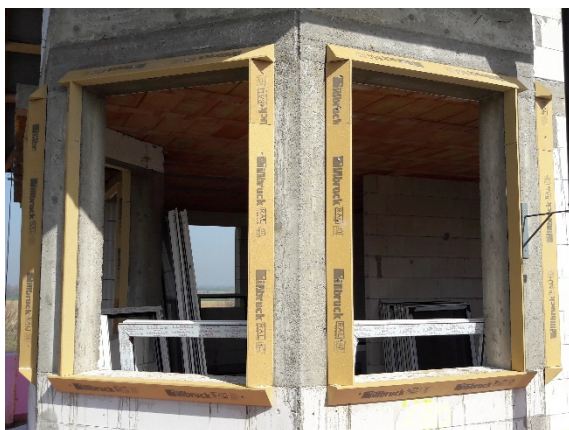
Obrázek 9 - Příklady vytvoření sekundárního ostění systémem Tremco - IIIbruck [Foto: autor]
