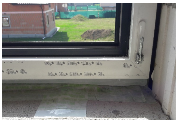
Obrázek 11 - Pohled na připojovací spáru z interiéru (vlevo) z exteriéru (vpravo) [Foto: autor]
