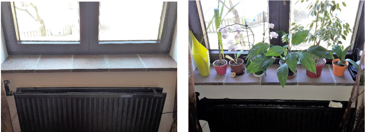
Obrázek 56 - Podmínky předpokládané výpočtem (vlevo), skutečné využití parapetu (vpravo) [Foto: autor]
