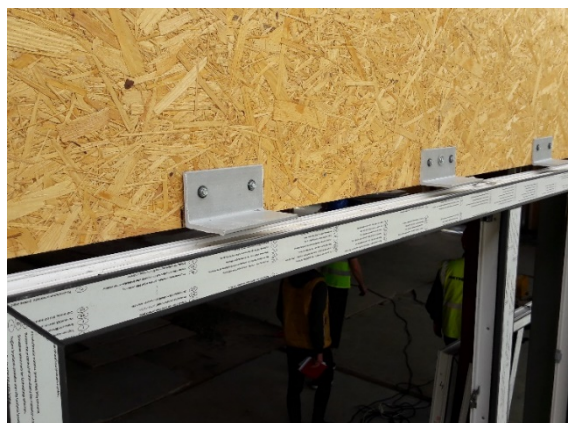
Obrázek 6 - Příklad nevhodného nesystémového řešení předsazené montáže [Foto: autor]
