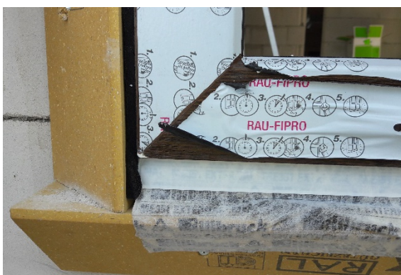
Obrázek 11 - Pohled na připojovací spáru z interiéru (vlevo) z exteriéru (vpravo) [Foto: autor]
