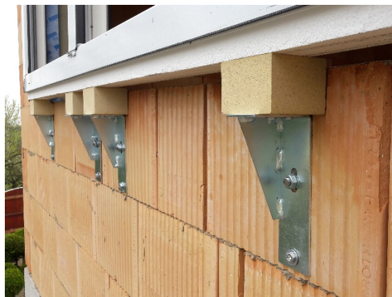
Obrázek 13 - Okenní rám osazený systémem Dafe - Purex - Basic [Foto: autor]
