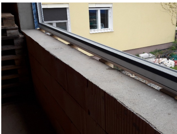
Obrázek 14 - Okenní rám osazený systémem Dafe Purex Basic (vlevo), kotva pro ostění a nadpraží (vpravo) [Foto: autor]
