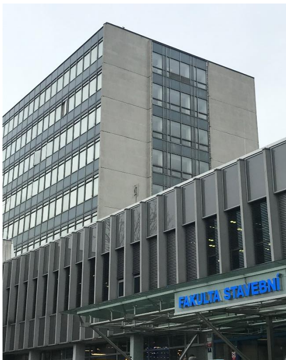
Obr. 8 Severovýchodní fasáda budovy B fakulty stavební [17]
