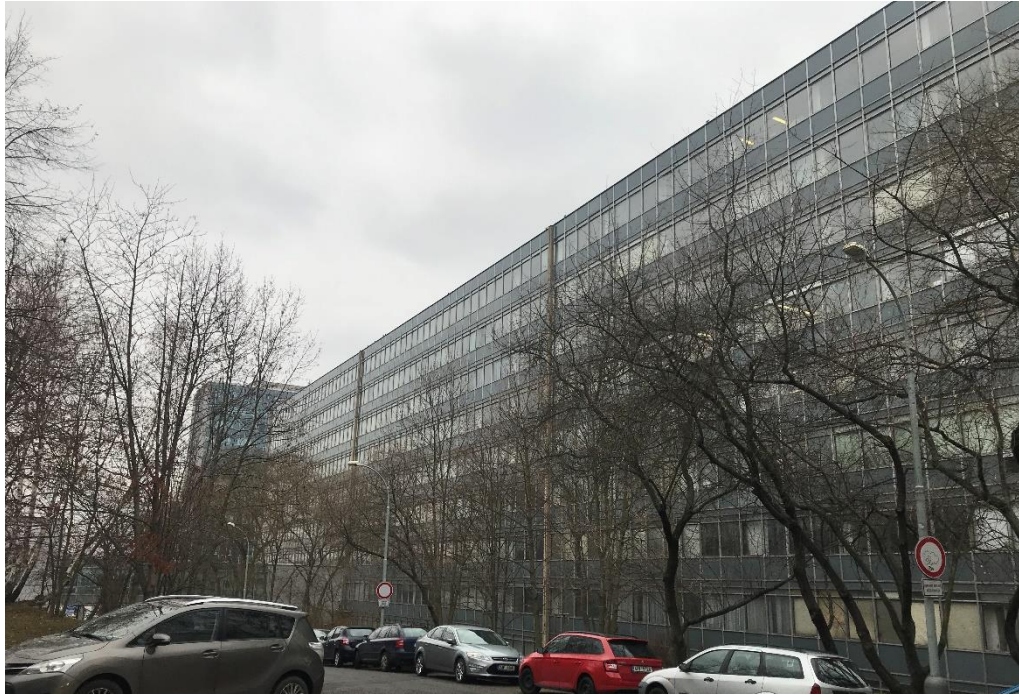
Obr. 7 Severozápadní fasáda budovy B fakulty stavební [17]
