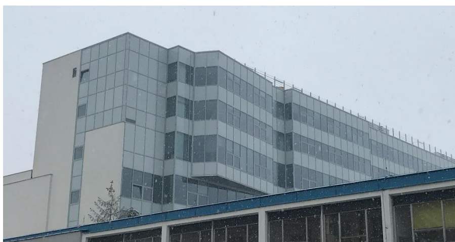
Obr. 2 Lehký obvodový plášť na budově ČVUT CIIRC po rekonstrukci [17]
