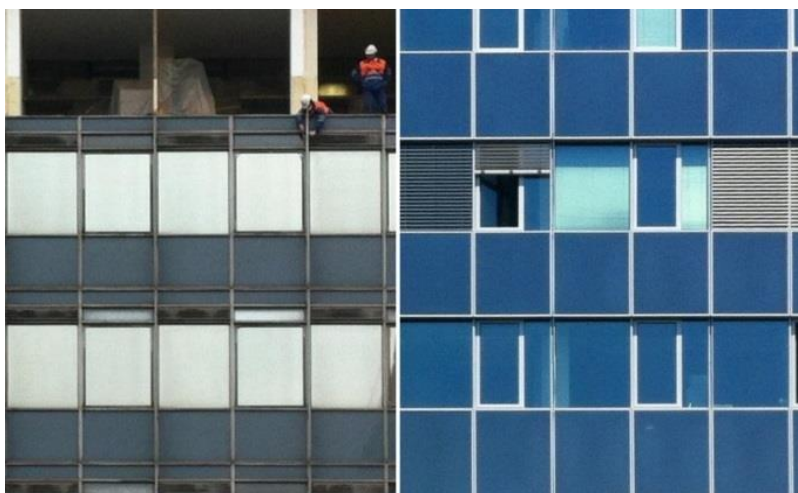
Obr. 1 Výměna lehkého obvodového pláště na budově A fakulty stavební [3]
