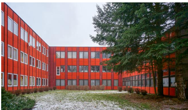
Obr. 4 Stávající budova COPHT [8]
