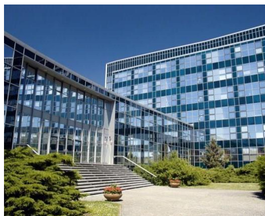
Obr. 14 Roštová konstrukce na budově ÚMCH [7]
