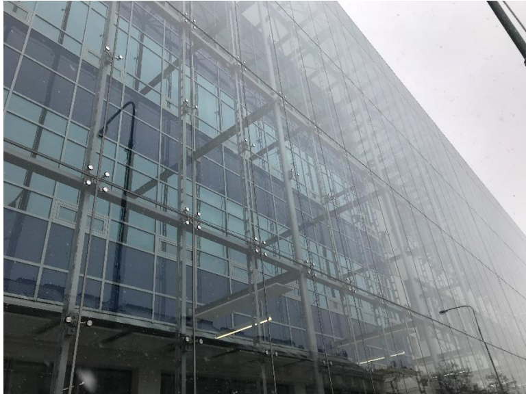
Obr. 17 Dvojitá konstrukce fasády na budově ČVUT CIIRC - rastrová konstrukce a LOP s bodovými úchyty skel [17]
