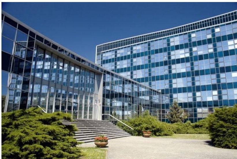
Obr. 3 Budova ÚMCH s novým lehkým obvodovým pláštěm [7]
