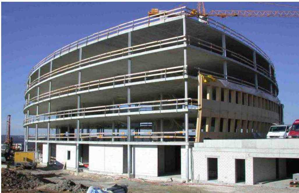
Obrázek 5: Průběh výstavby administrativní budovy Energon, převzato z [6]
