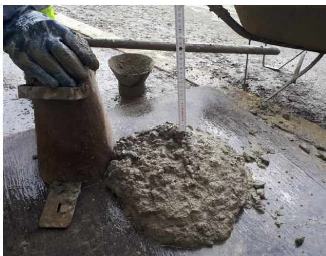
Obr. 65- Zkouška sednutí kužele, receptura: PZ39A-S50
