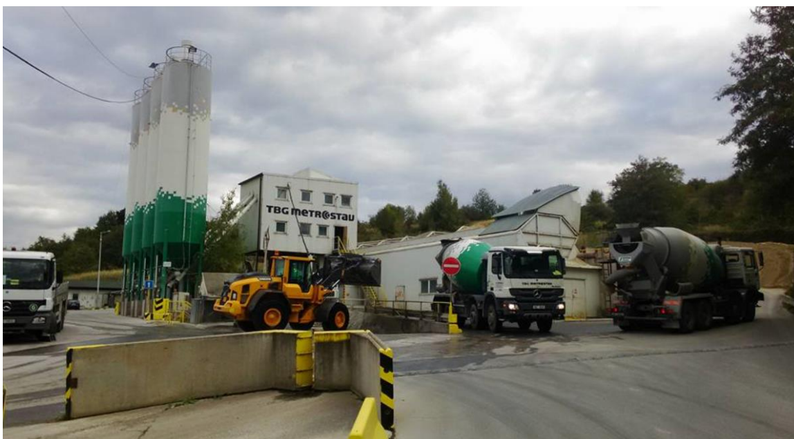
Obr. 16- Betonárna TBG Metrostav v Radlicích
