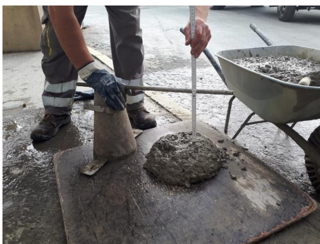
Obr. 68- Zkouška sednutí kužele, receptura: PZ39B-S50
