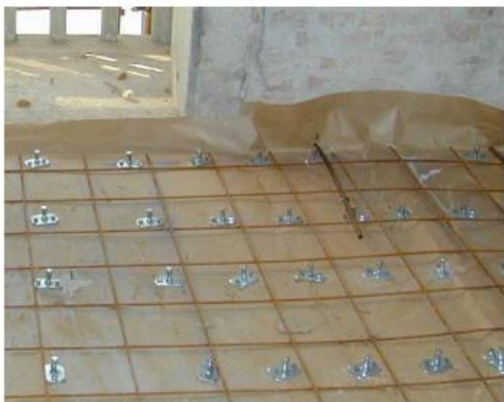
Obrázek 6: Rekonstrukce dřevěného trámového stropu – vytvoření kompozitu
