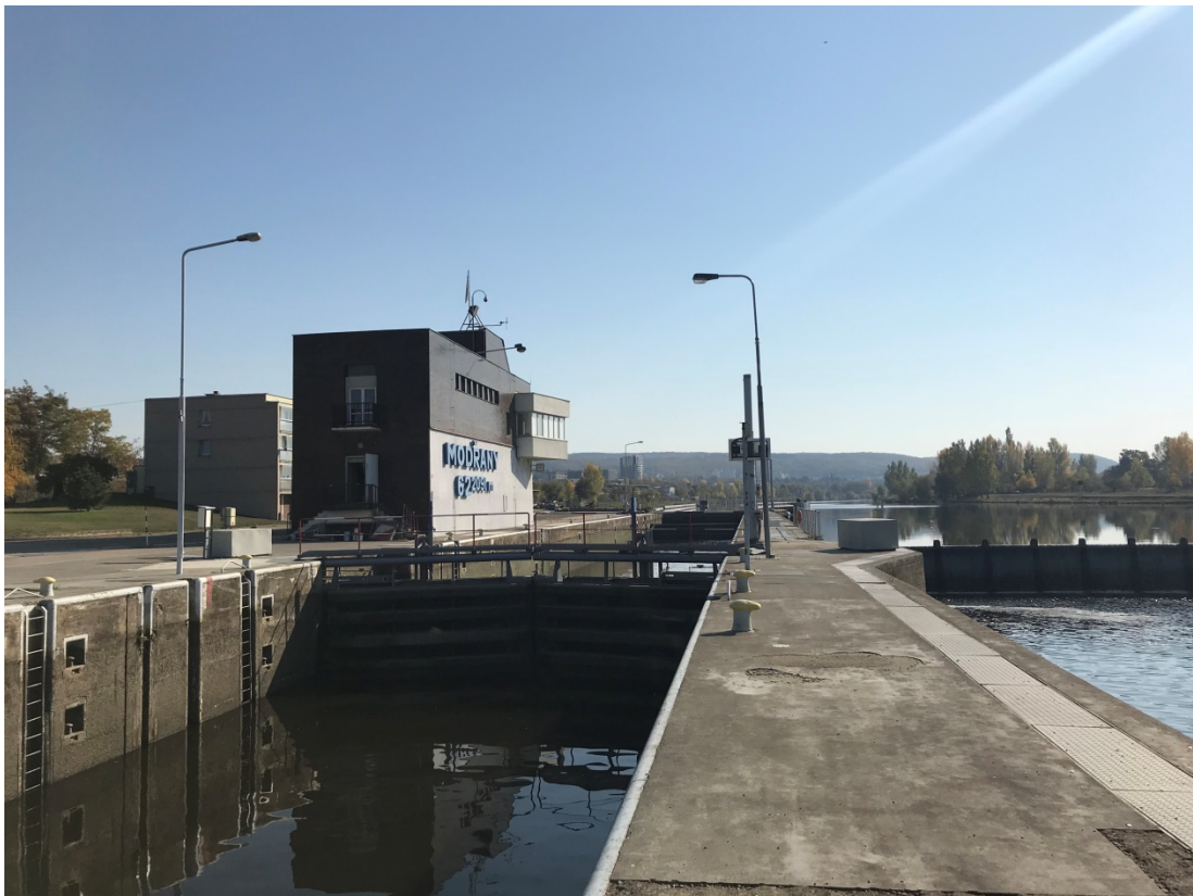
Obrázek 4: Pohled na střední vrata plavební komory a velín VD Modřany
