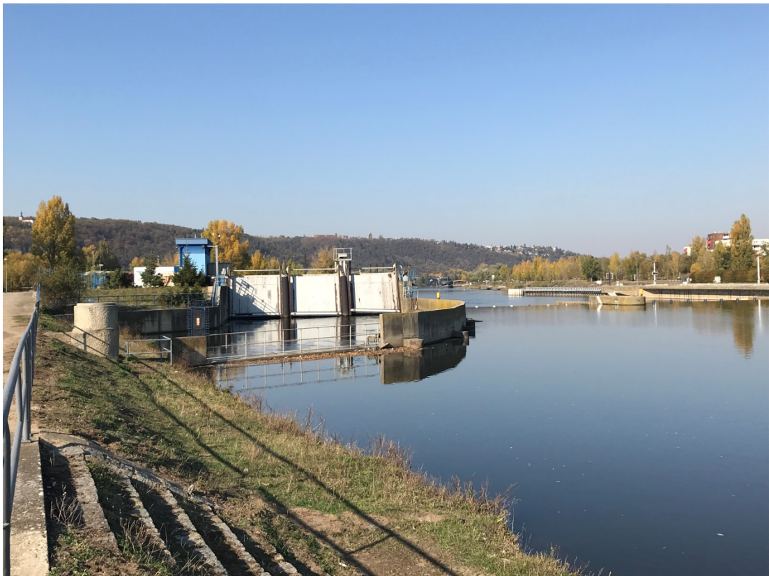
Obrázek 5: Pohled po vodě na malou vodní elektrárnu
