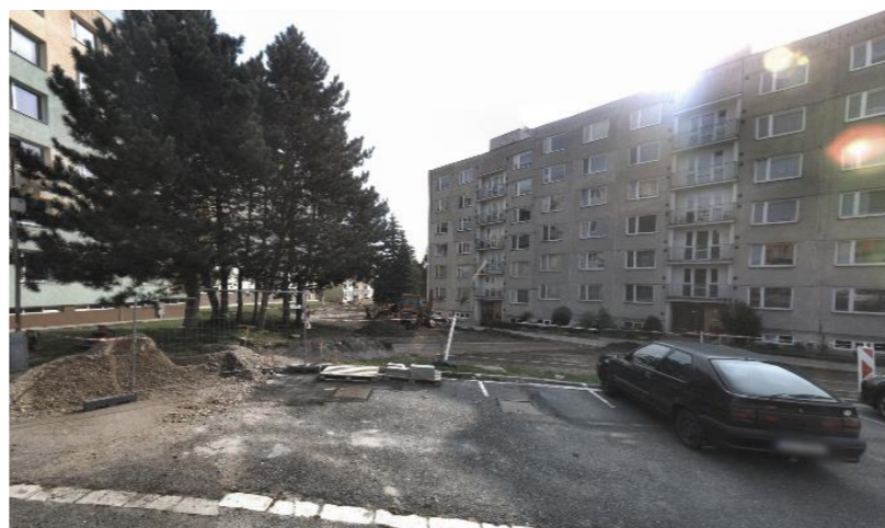
Rekonstruovaná část na jihu sídliště
