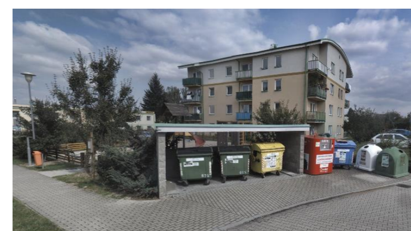
Dostatečně dimenzované přístřešky na kontejnery
