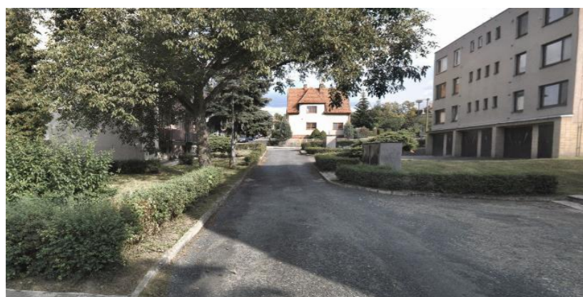
Prostor mezi bytovými domy
