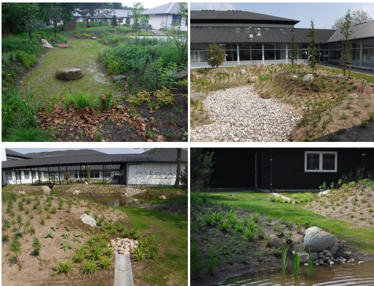
Obr. 8: Odpojení dešťové vody a infiltrace v deštných zahradách ve škole Nørregård [13]
