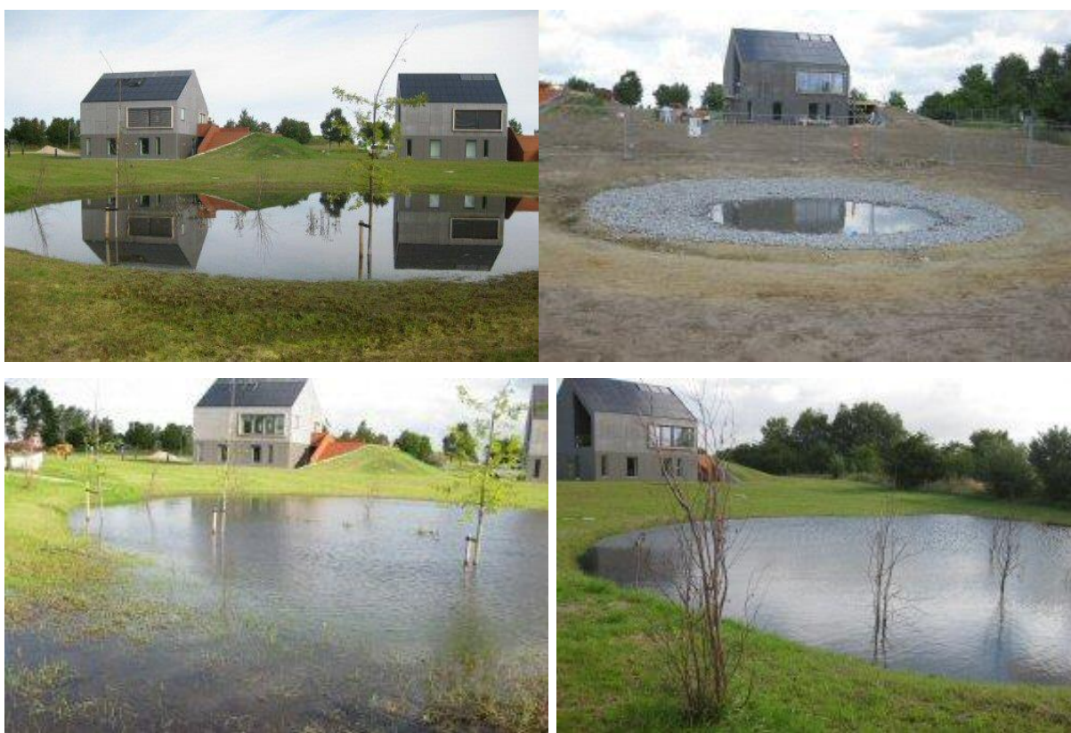
Obr. 13: Zavedení travivodů a deštných zahrad v EnergyFlexHouse [17]
