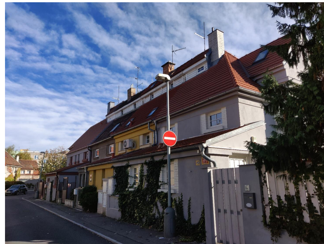
Obrázek č. 13 – Řadový dům typu A s dostavěným zádveřím, autor: Miroslav Preclík
