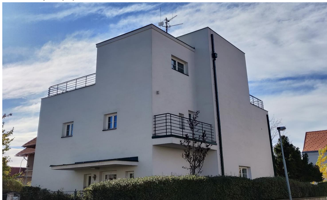
Obrázek č. 78 – Příklad zachování původního zábradlí balkonu u viladomu, autor: Miroslav Preclík
