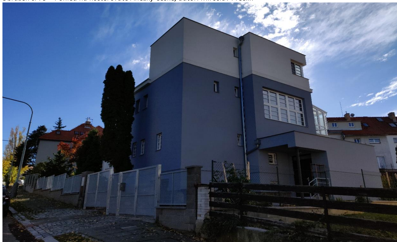
Obrázek č. 80 – Příklad rekonstrukce viladomu, autor: Miroslav Preclík
