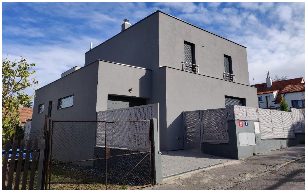
Obrázek č. 83 – Příklad novostavby na Spořilově, autor: Miroslav Preclík
