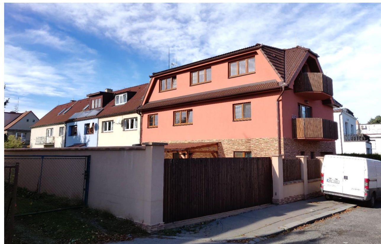
Obrázek č. 66 – Příklad nevhodného vikýře – typ č.5, autor: Miroslav Preclík
