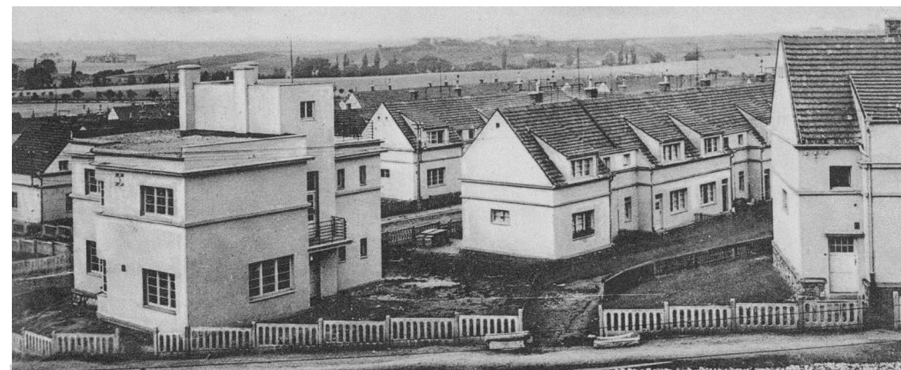
Obrázek č. 9 - Historická fotografie původní zástavby Spořilova, pohled z ulice, rok 1928, zdroj: sporilov.info
