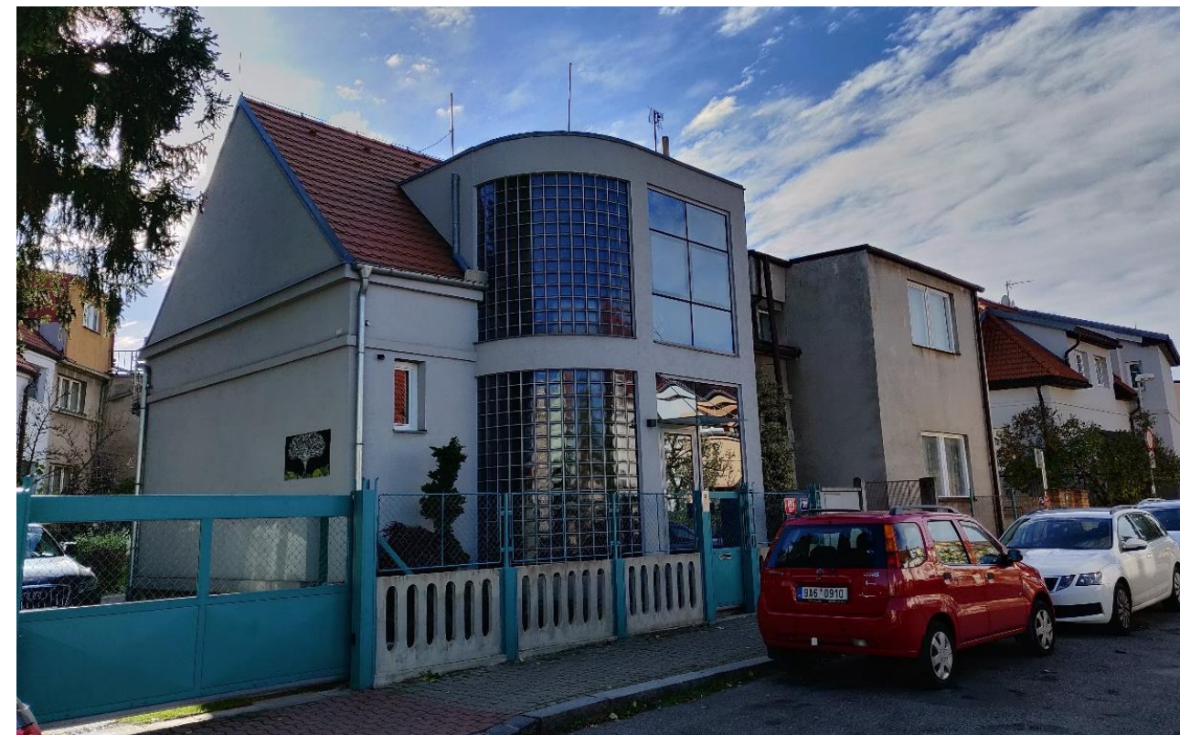
Obrázek č. 85 – Moderní přístavba zádveří s patrem, autor: Miroslav Preclík
