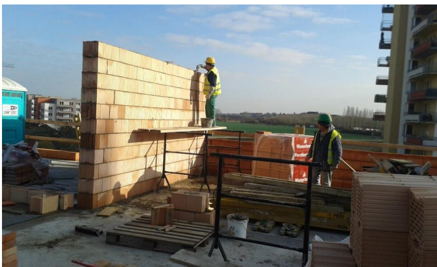
Obr. č. 11: Pracovní lešení při zdění s výškou 1,5m. 1 [autor]
