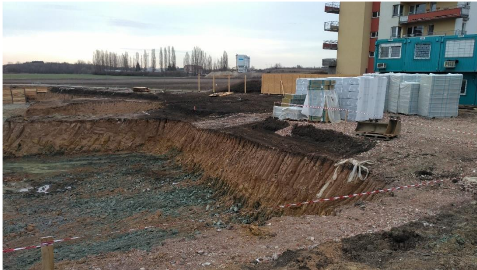
Obr. č. 9: Páska ohraničující vysvahovanou hranu stavební jámy. [autor]
