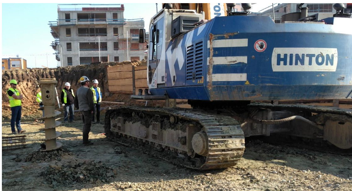
Obr. č. 13: Pilotovací stroj a zajištěné vrtné zařízení. [autor]
