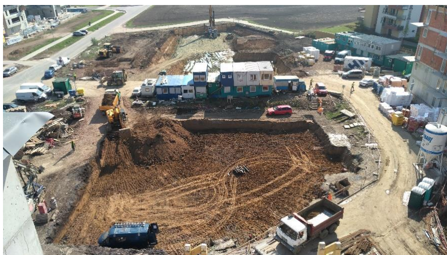
Obr. č. 8: Zařízení staveniště při provádění zemních prací. [autor]
