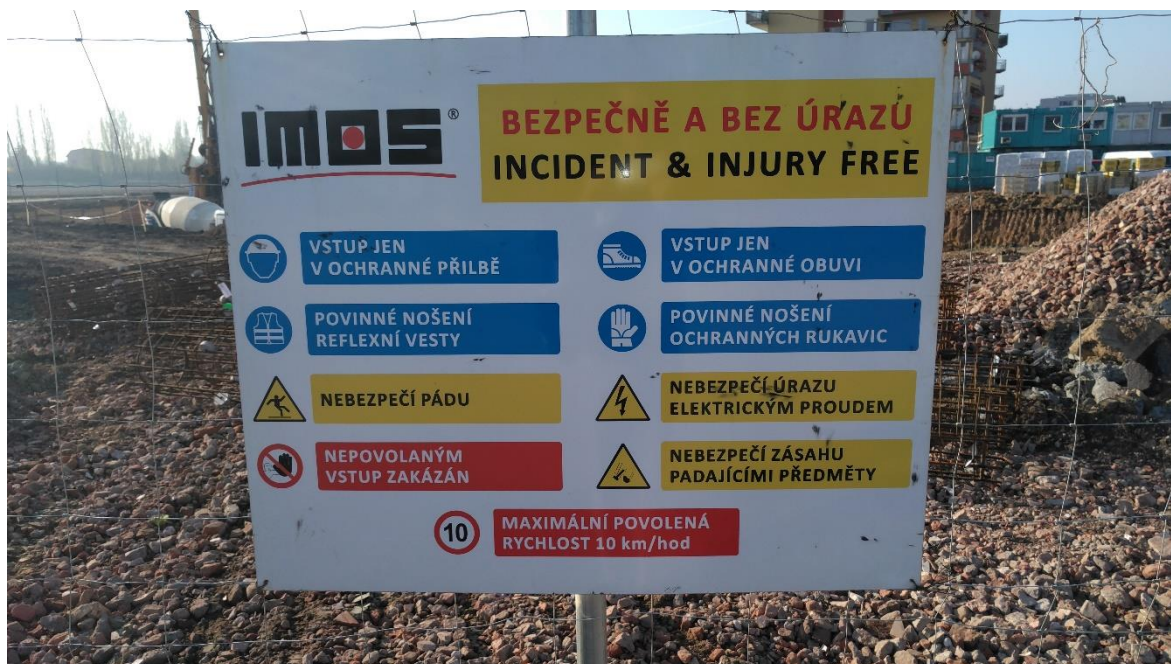
Obr. č. 5: Bezpečnostní cedule vymezující podmínky vstupu na staveniště. [autor]
