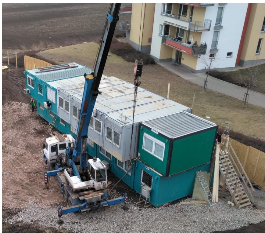
Obr. č. 14: Stabilizovaný autojeřáb při zdvihání břemene. [autor]
