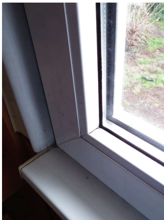
Foto 5: Okenní výplň s izolačním dvojsklem / Foto 6: Detail rámu okna s izolačním dvojsklem
