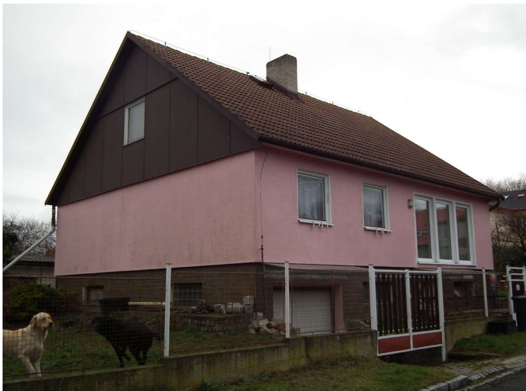
Foto 1: Pohled na objekt
