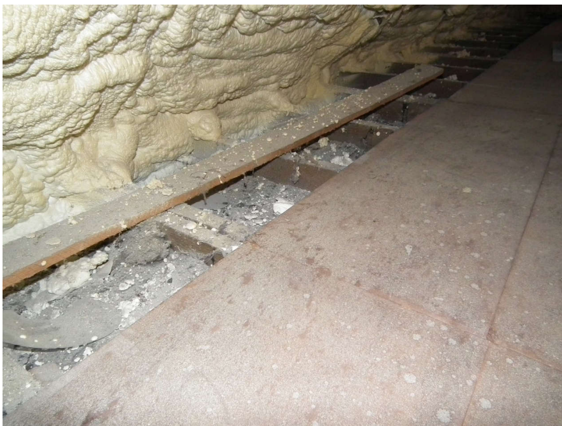
Foto 14: Podkroví, pohled na zateplené krovu při podlaze
