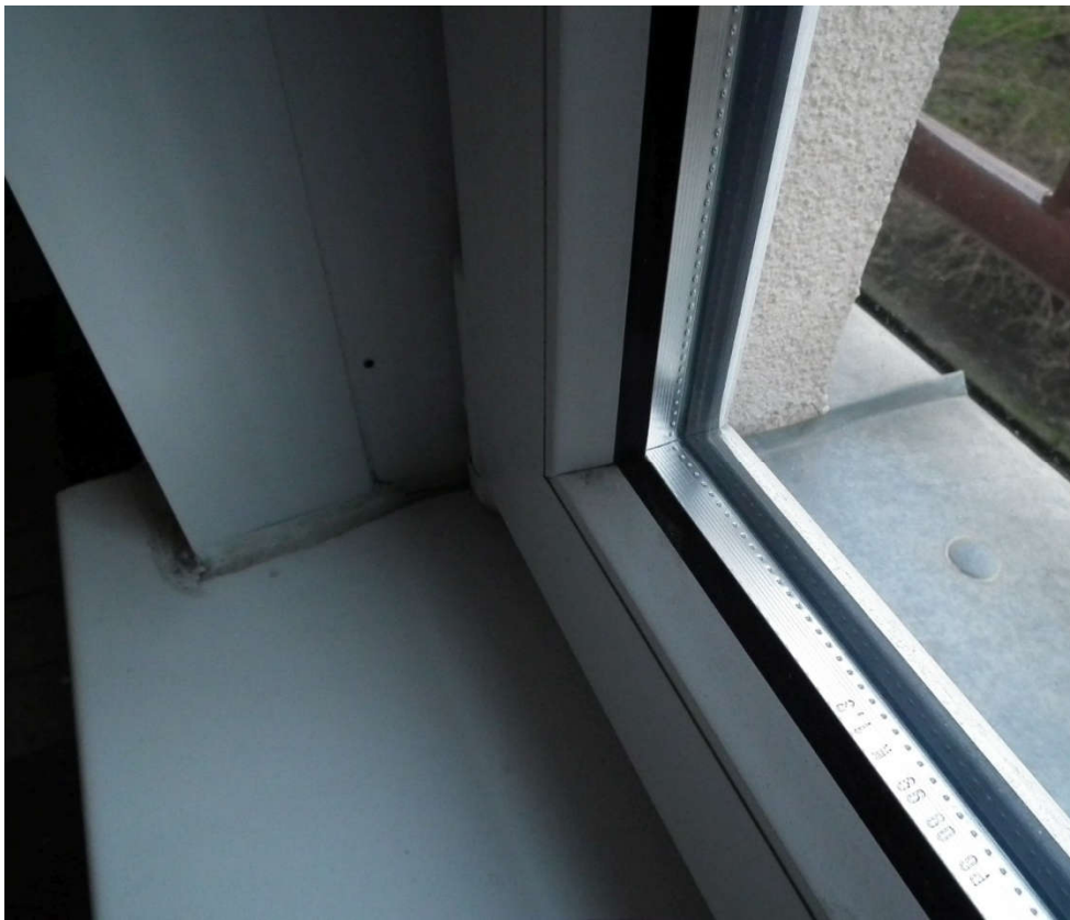
Foto 9: Okno ve společných prostorách - detail
