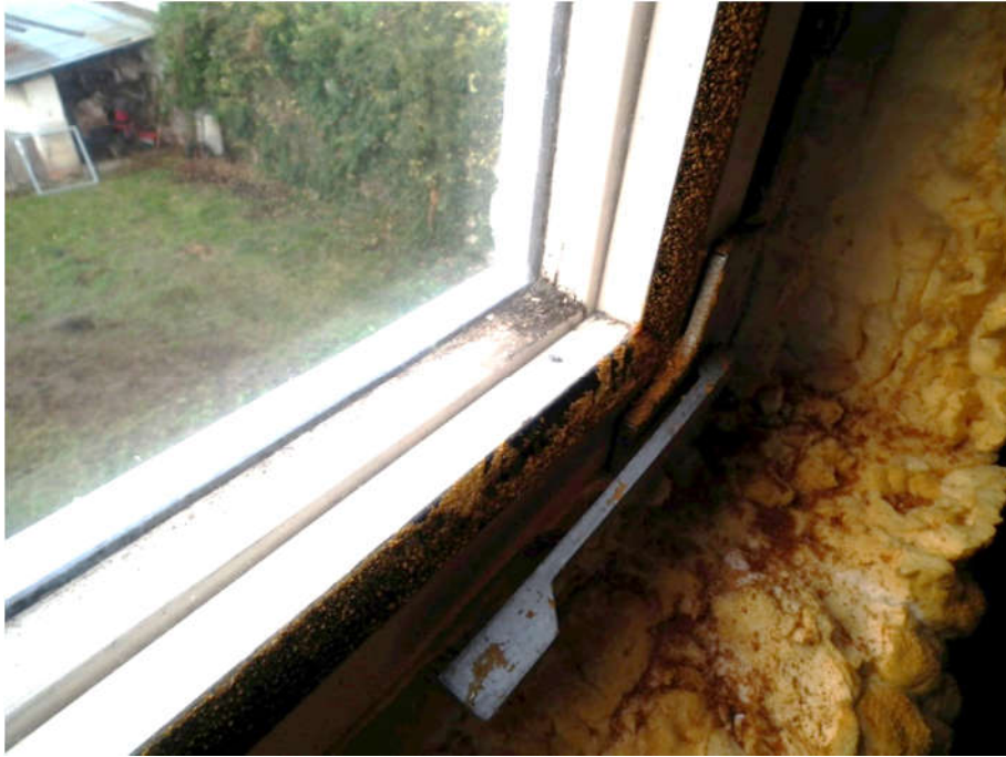
Foto 8: Detail rámu typického okna
