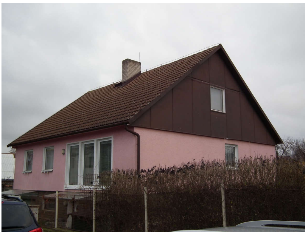
Foto 2: Pohled na objekt
