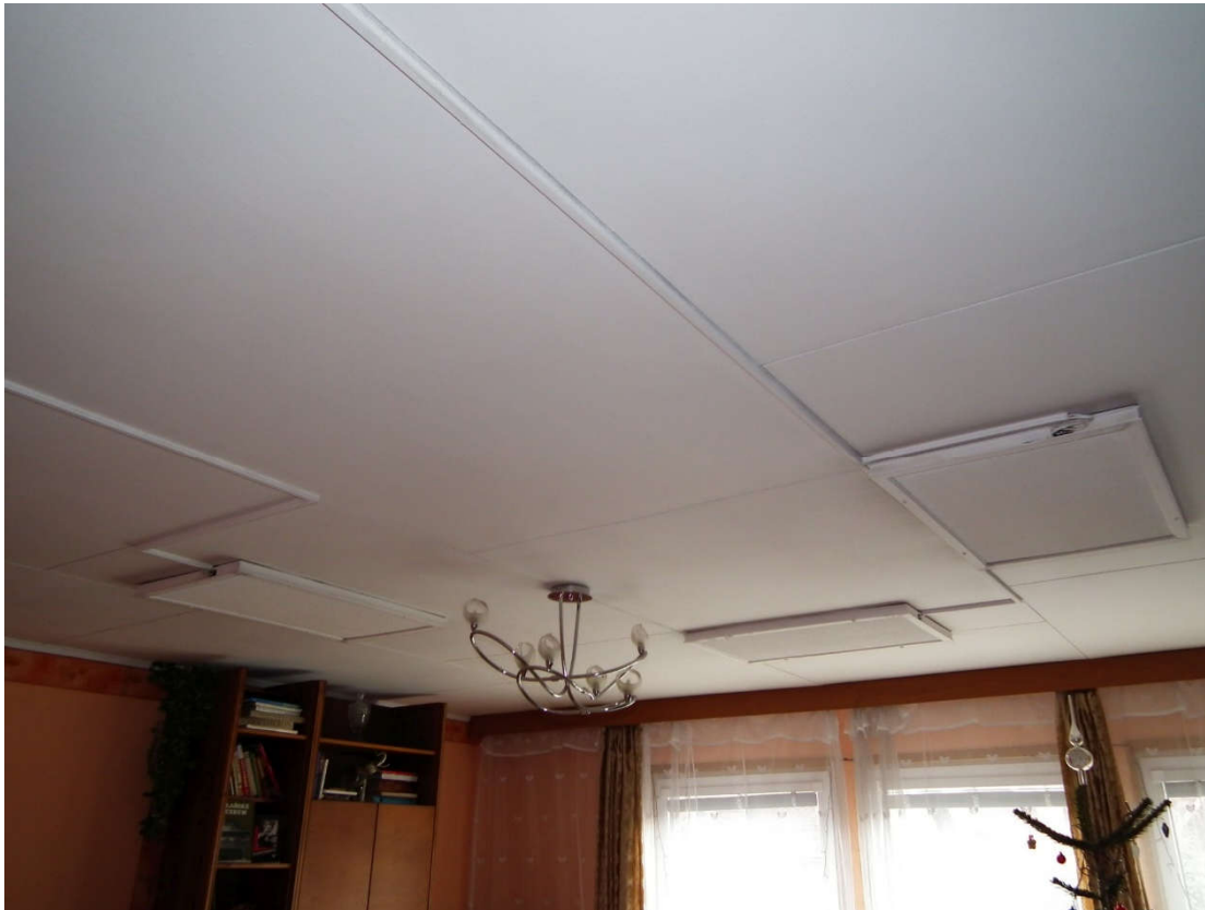
Foto 15: Pohled na strop a elektrické ohřívací panely
