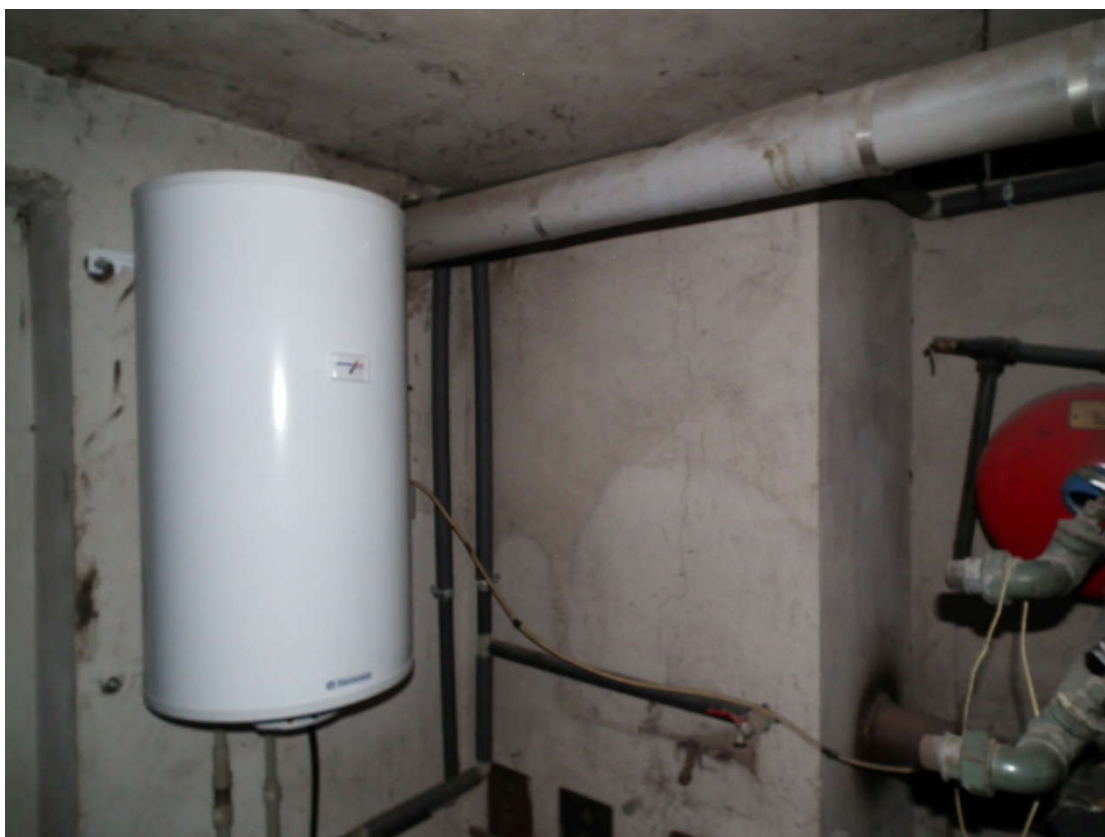
Foto 17: Elektrický bojler a vpravo část potrubí od kotle na pevná paliva a expanzní nádoba
