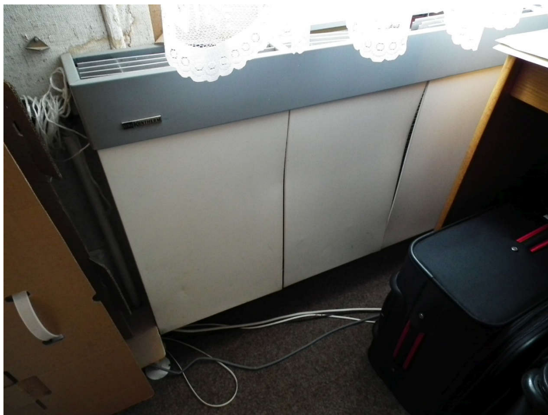
Foto 18: Staré nepoužívané radiátory napojené na rozvody od kotle na pevná paliva
