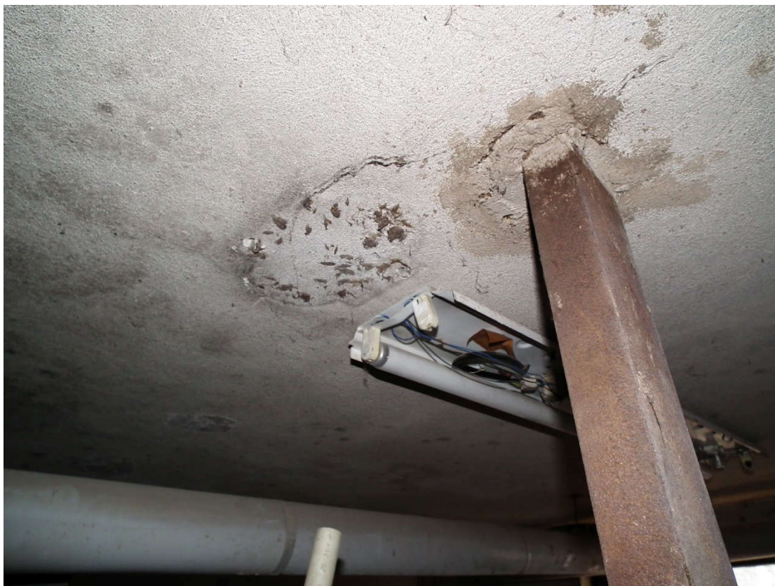
Foto 16: Pohled na nezateplený strop v suterénu
