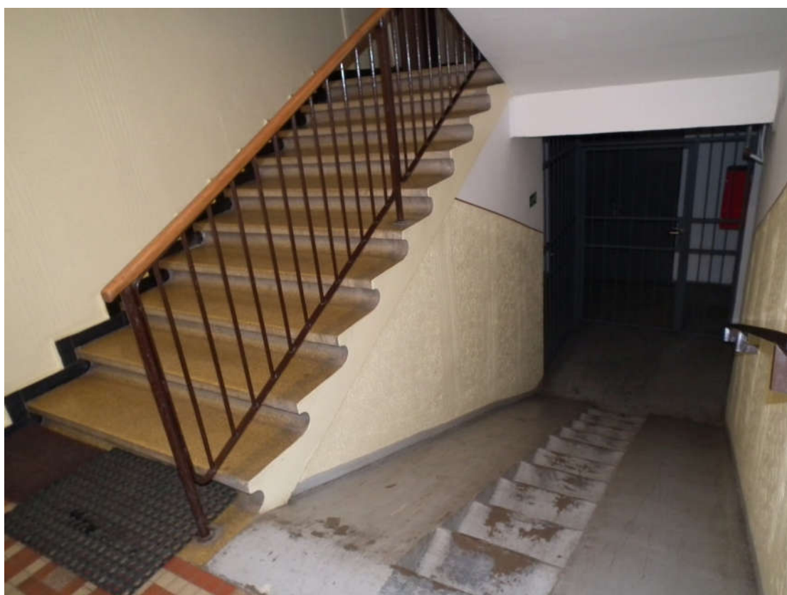
Foto 4: Přízemí – pohled od hlavního vchodu
