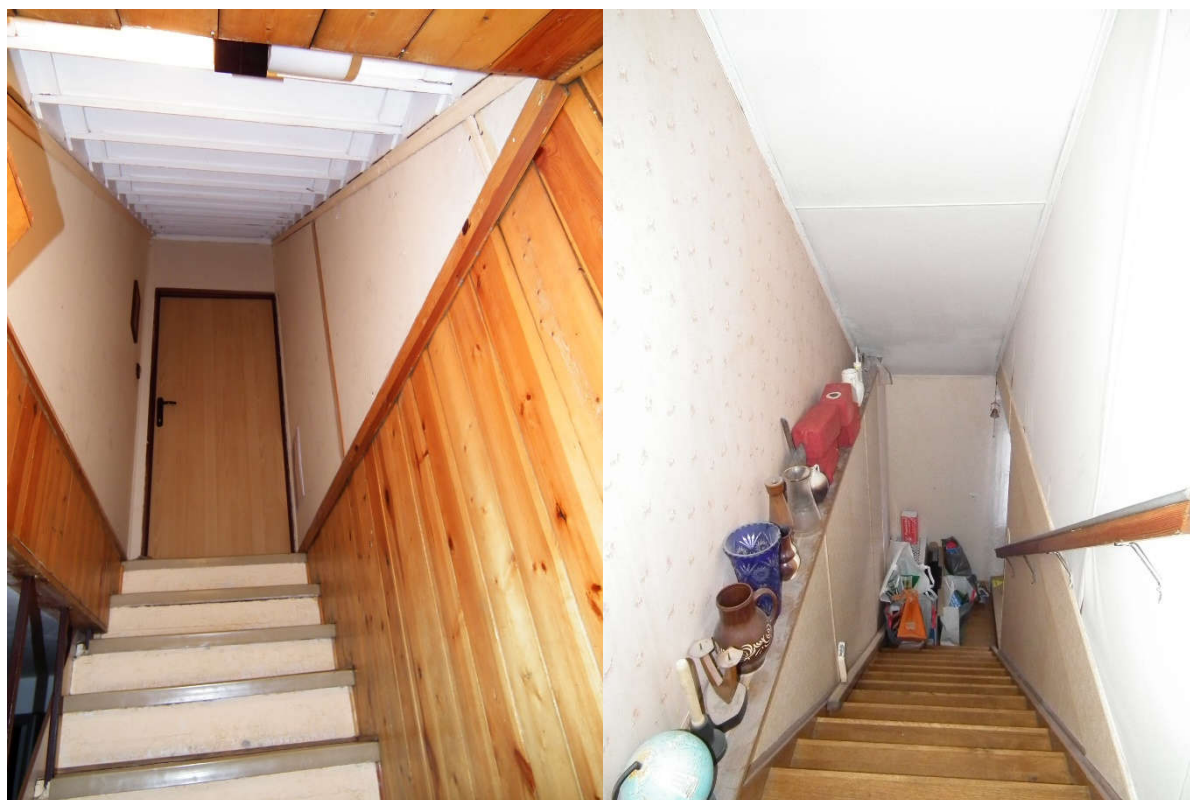
Foto 11 a 12: Schody ze suterénu do obytného podlaží; Schody z podkroví do obytného podlaží
