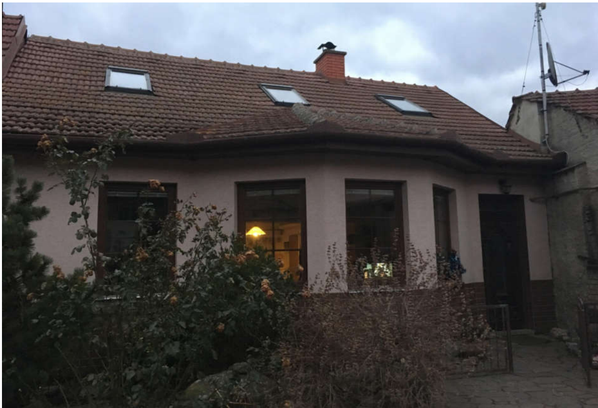
Foto 1: Pohled na objekt z jihozápadu
