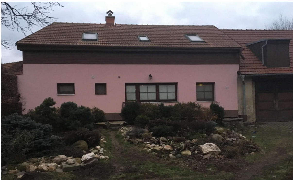
Foto 2: Pohled na objekt
