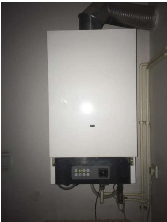
Foto 9: Plynový kotel Atoma 12 - 24 kW
