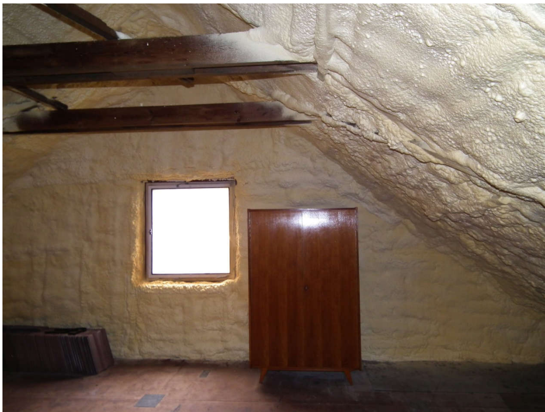
Foto 13: Podkroví, pohled na zateplené krovu
