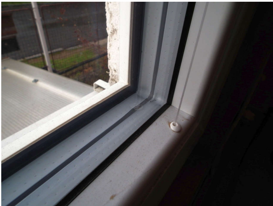
Foto 4: Detail rámu okna s izolačním trojsklem
