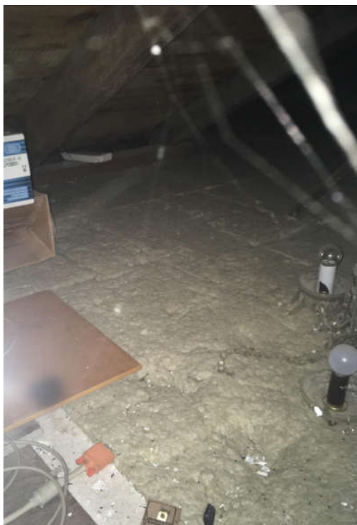
Foto 8: Pohled na půdu a zateplení půdy/střechy
