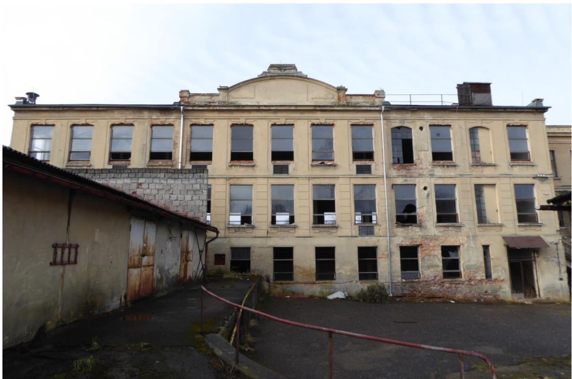
Hlavní budova: východní pohled
