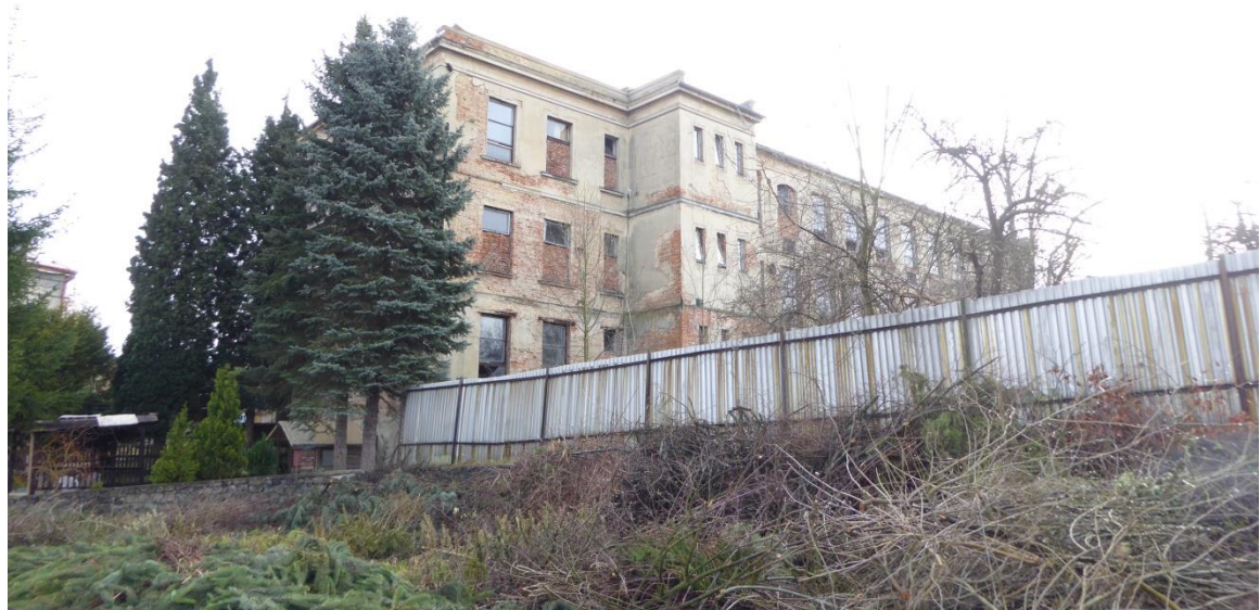
Hlavní budova: severozápadní pohled
