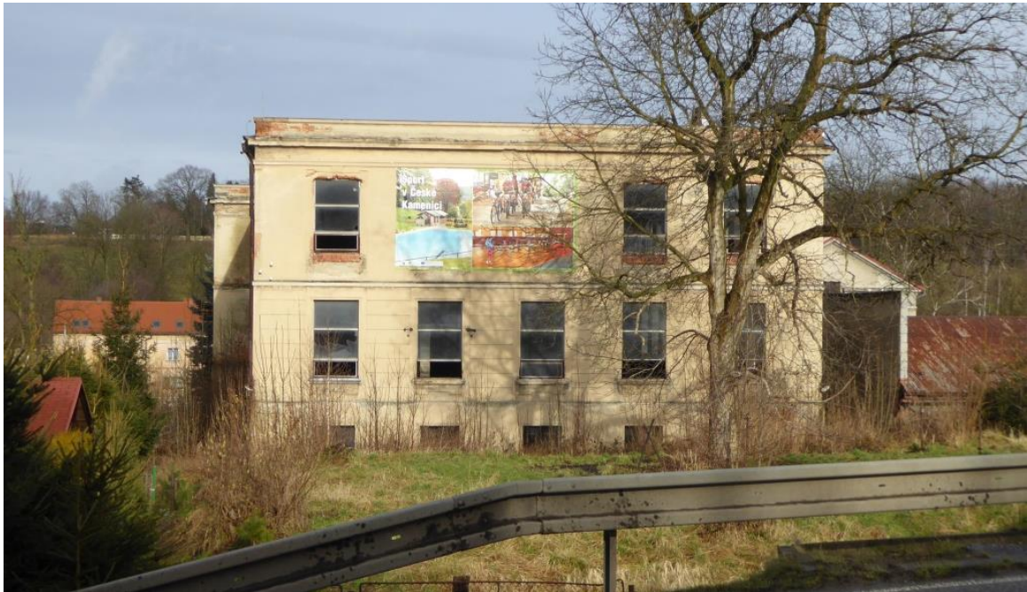
Hlavní budova: jižní pohled
