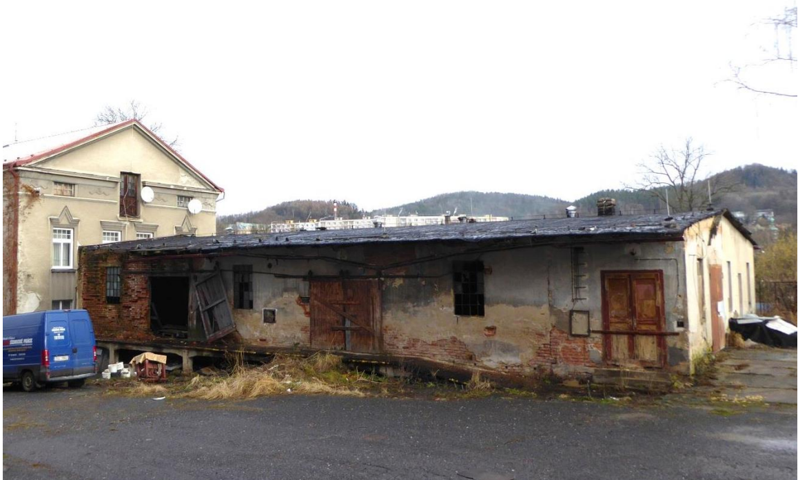
Budova skladů určená k demolici
